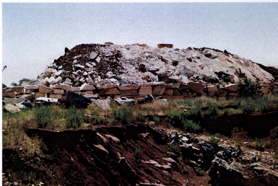
Figura 14.IV - A utilização de blocos não comercializáveis como muro de suporte é uma solução económica e eficaz na estabilização de aterros/escombreiras.
