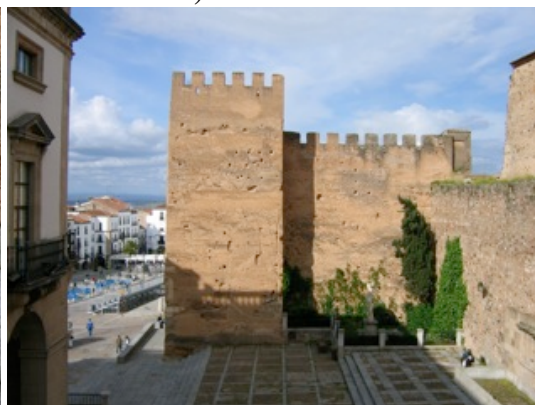
figs. 168-9-Cáceres-detálhe da taipa militar e torre albarrã ligada por cortina, s/ arco.
