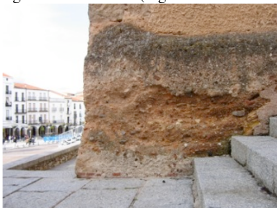
figs. 168-9-Cáceres-detálhe da taipa militar e torre albarrã ligada por cortina, s/ arco.
