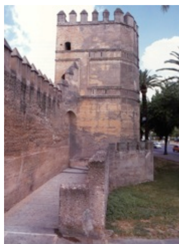
181-3. torres poligonais almóadas: Arco da Encarnação (Elvas); torre em alvenaria da muralha de Sevilha; poligonal da puerta da Macarena, em taipa (Sevilla).
