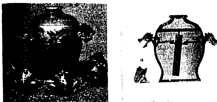
Figura 6 - “sismoscópio” de Chang Heng . Este instrumento de tamanho considerável, com cerca de dois metros de diâmetro construído em bronze, não chegou aos nossos dias, mas é conhecido a partir de documentos da época. Qualquer abalo accionava o pêndulo central, que provocava a abertura da boca do dragão, da qual era largada uma esfera metálica que caía na boca de um dos oito sapos, assinalando dessa maneira. a direcção de propagação do sismo.
