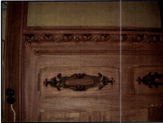
Fig. 236 – Casa do Pombal. Afife. Lambrim da sala de jantar. Observem-se os apainelados em estuque a fingir madeira. Fingem-se também aplicações de ornamentos metálicos.
