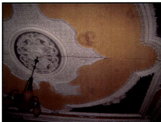
Fig. 323 – Casa do Outeiro. Felgueiras. Tecto de sala de estar, em estuques policromados. As cores são originais (inícios do séc. XX).
