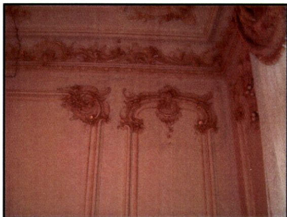
Fig. 352 – Casa do Pombal. Afife. Estuques que revestem as paredes do hall .
