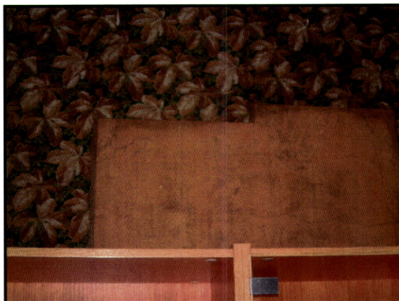
Fig. 211 – Casa de Jogueiros. Felgueiras. Sobre um fingido de madeira sobre estuque foi aplicado um papel decorativo.
