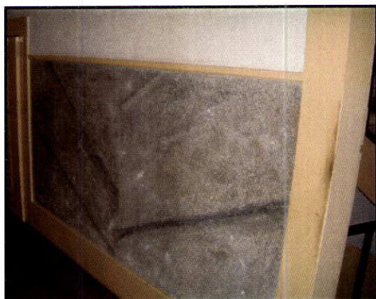
Fig. 206 – Casa do Pinto. Afife. Fingido de granito sobre estuque em técnica de stucco-lustro .
