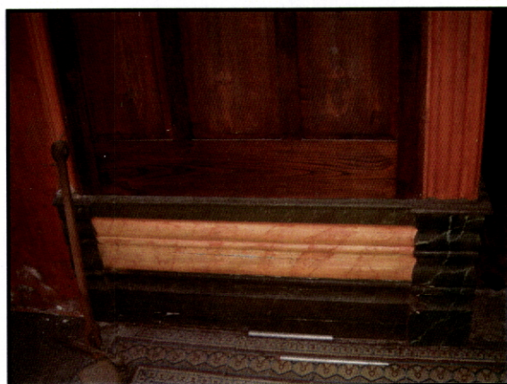
Fig. 260 – Casa do Assento 2 – Rodapé a imitar mármore de várias cores.
