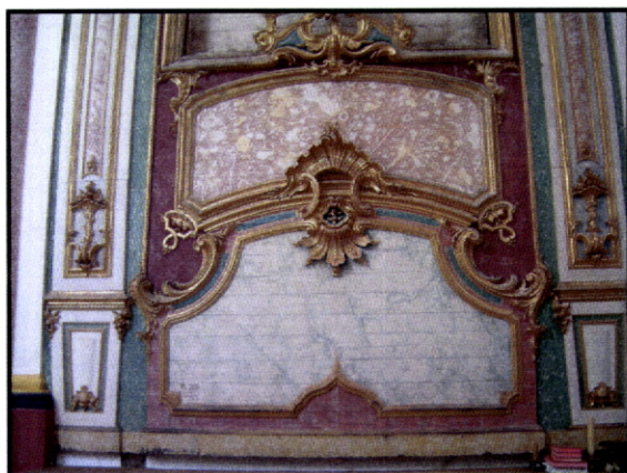
Fig. 265 – Mosteiro de Pombeiro. Felgueiras. Talha pintada a óleo, a simular marmoreados. Não se restauraram os marmoreados por falta de testemunhos de cor fidedignos.
