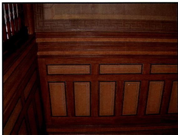
Fig. 220 – Fundação Jorge Antunes. Vizela. Apainelado de madeira fingida sobre estuque. Escada de acesso ao primeiro piso.
