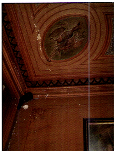
Fig. 227 – Casa do Outeiro. Felgueiras. Pormenor do lambrim pintado com um fingido de madeira. É visível o destacamento da camada cromática outrora aplicada sobre o estuque.
