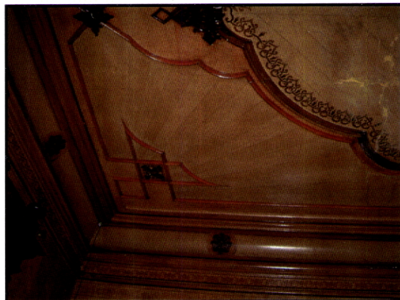
Fig. 217 – Casa Branco de Faria. Vizela. Canto do tecto da sala de jantar com aplicações de molduras pintadas a óleo, em estuque, a fingir madeira.
