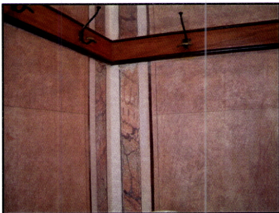
Fig. 195 – Casa Painhas. Viana do Castelo. Parede do “quarto dos cabides”, em stucco-lustro . Atente-se no tom rosa de fundo, intencionalmente carregado.
