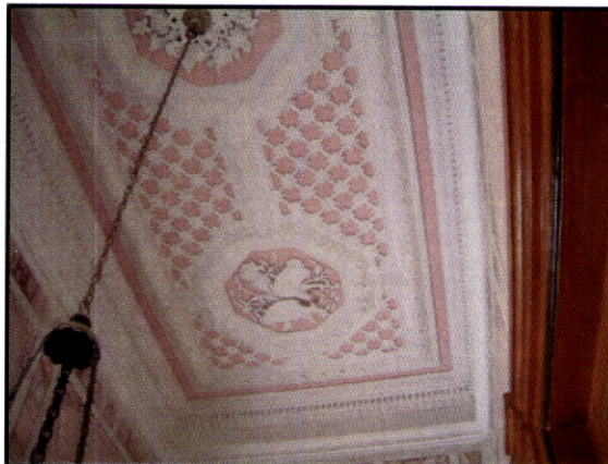
Fig. 399 – Casa Painhas. Viana do Castelo. Estuques decorativos do tecto de um corredor.
