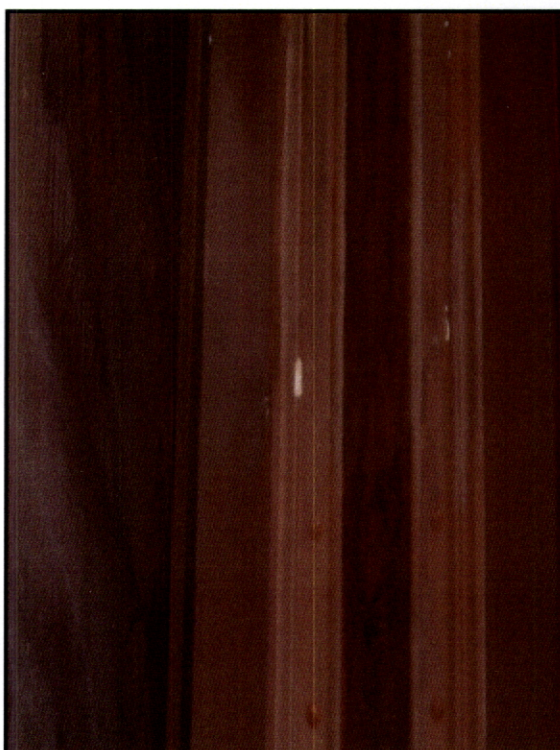
Fig. 233 – Vila Beatriz. Póvoa de Lanhoso. Pormenor de um canto, onde se vê o realismo do fingido de madeira.
