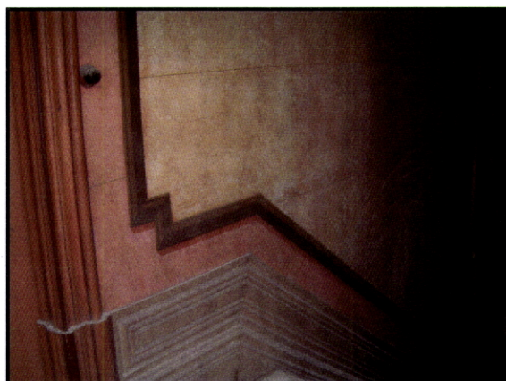
Fig. 291 – Casa do Assento 1. Felgueiras. Faixa colorida a emoldurar um paramento em stucco-lustro .
