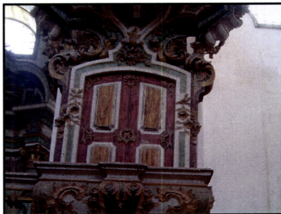
Fig. 266 – Mosteiro de Pombeiro. Felgueiras. Porta fingida de púlpito. A pintura simula madeiras exóticas.
