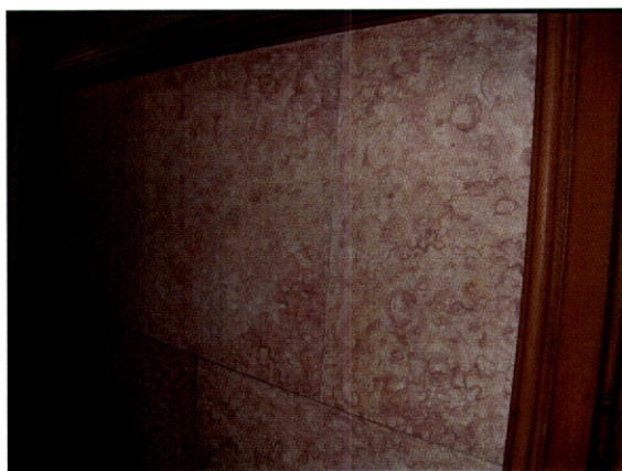
Fig. 208 – Casa do Pombal. Afife. Revestimento em stucco-lustro de uma parede de um corredor interior. Trata-se também de um trabalho de grande qualidade de execução e acabamentos.
