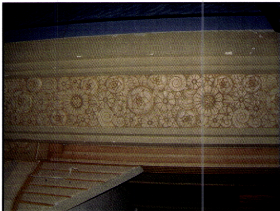
Fig. 358 – Casino Afifense. Afife. Faixa em estuque, de inspiração Art Deco , que emoldura a boca do palco do salão de festas.
