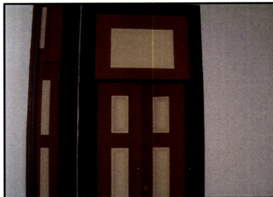
Fig. 287 – Teatro Club. Póvoa de Lanhoso. Fase do restauro que foi eliminada por não obedecer ao fundo indicado pelo fingidor.
