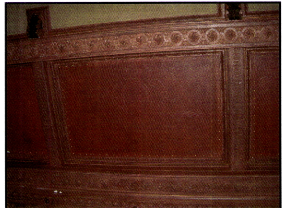
Fig. 239 – Casa do Pombal. Afife. Caixotão em estuque a fingir madeira. No centro, finge-se couro com grande realismo.
