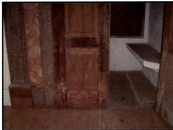
Fig. 268 – Mosteiro de Pombeiro. Felgueiras. Marmoreado pintado a óleo sobre madeira. À estrutura da porta foi aplicada uma outra, de madeira, onde também se simula um fingido de granito.
