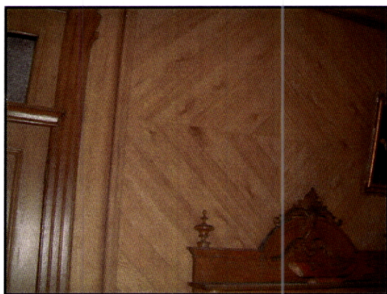
Fig. 246 – Casa Paínhas. Viana do Castelo. Parede da sala de jantar com um fingido de madeira sobre estuque. Atente-se no requinte do acabamento.
