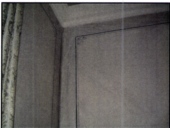
Fig. 307 – Casa Painhas. Viana do Castelo. Paredes em stucco-lustro com molduras pintadas a estampilha.
