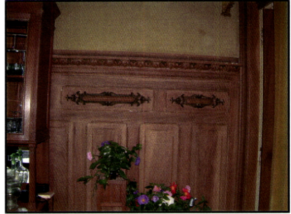
Fig. 237 – Casa do Pombal. Afife. Plano do lambrim fingido. O acabamento do fingido de madeira é intencionalmente fosco. Ao toque, a sua textura é áspera, simulando a da madeira com grande realismo.
