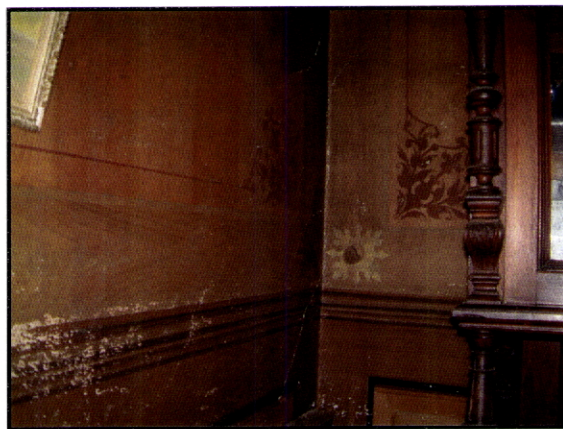
Fig. 228 – Casa do Outeiro. Felgueiras. Sala de jantar. O desenho das tábuas é feito com o estuque ainda fresco. Posteriormente, dá-se o fingido a óleo, e só aí se pintam os nós e os veios da madeira.
