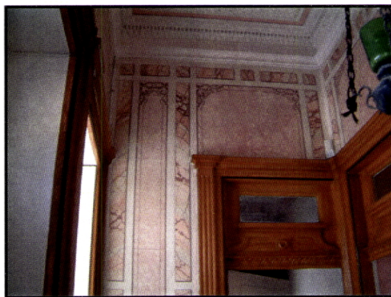
Fig. 198 – Casa Painhas. Viana do Castelo. Paredes do átrio da entrada, emolduradas por frisos pintados.
