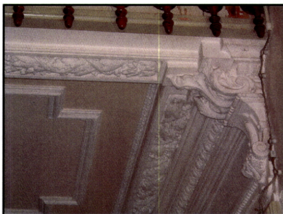
Fig. 357 – Casa do Pombal. Afife. Decoração de ordem clássica. Tecto do vão das escadas de acesso ao primeiro piso.
