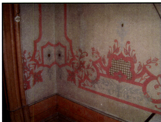
Fig. 298 – Casa do Outeiro. Felgueiras. Rodapé em marmoreado fingido. A parede está pintada com uma moldura decorativa a óleo.
