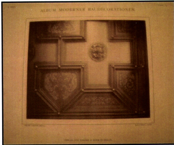
Fig. 249 – Modelo de tecto artesoado em estuque. Os caixotões estão decorados com fingidos de tecido adamascado. Encontramos semelhanças com o esquema decorativo de Vila Beatriz.
