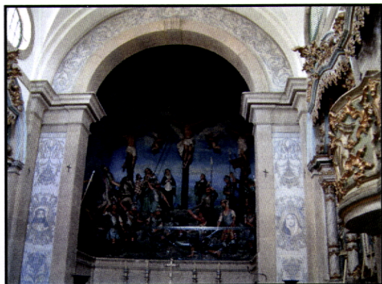
Fig. 258 – Capela do Calvário. Ovar. Arco pintado com simulação de azulejo (Apêndice 2, pp. 151-153).
