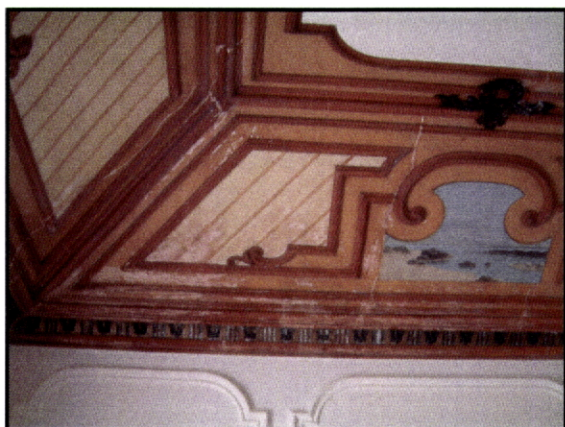
Fig. 243 – Casa do Alves. Afife. Tecto em masseira da sala de jantar. Fingido de madeira sobre estuque.
