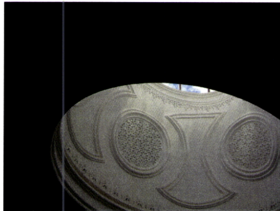
Fig. 318 – Casa do Barão. Cabeceiras de Basto. Lanternim decorado com medalhões de estuque rendilhados.
