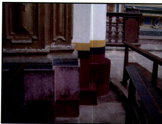
Fig. 419 – Mosteiro de Pombeiro. Felgueiras. Bases das colunas da nave principal. Em primeiro plano, vê-se o testemunho cromático que terá servido de base à afinação de cor para os tons escuros das colunas em pedra.
