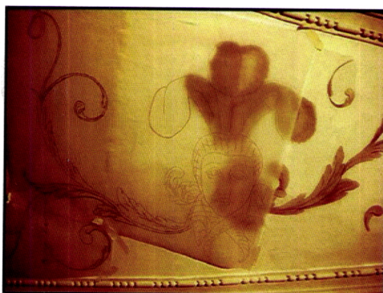
Fig. 426 – Paço Episcopal. Porto. Pormenor do decalque do desenho sobre a parede em estuque. (Foto Belbetões).
