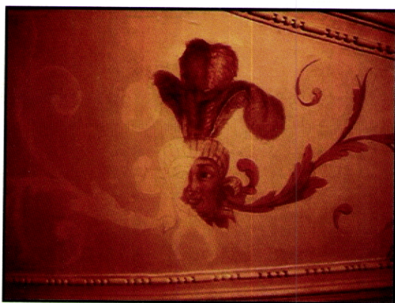
Fig. 425 – Paço Episcopal. Porto. Exemplo de uma reintegração figurativa. A repetição do desenho permite esta operação, uma vez que há testemunhos fidedignos. (Foto Belbetões).
