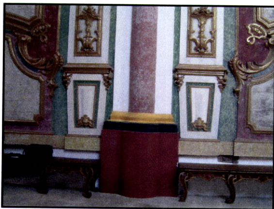
Fig. 418 – Mosteiro de Pombeiro. Felgueiras. Pormenor dos marmoreados das colunas fingidas da capela-mor. Note-se o contraste das três cores que cobrem as bases em pedra da coluna.
