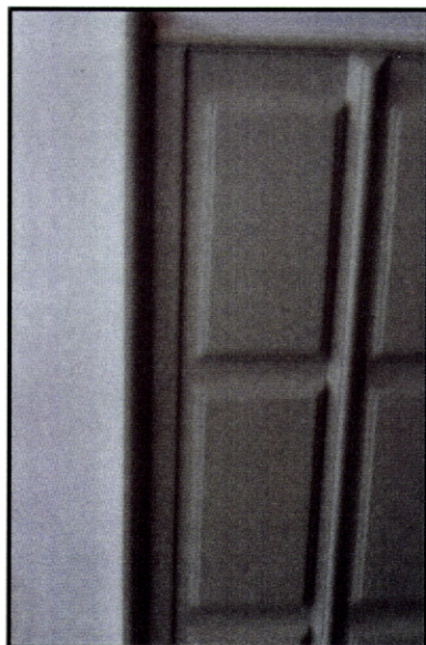
Fig. 12 -Madeira com preparada com litopone e pronta a levar o “banho” para posterior execução do fingido.
