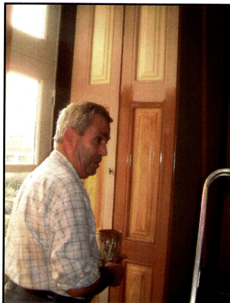
Figs. 3, 4 e 5 – O pintor fingidor Alberto Cavalheiro aplica o “banho” sobre uma base previamente preparada à cor, antes de iniciar o trabalho de fingimento dos veios e nós. (Obra de recuperação do salão nobre do Theatro Club da Póvoa de Lanhoso)
