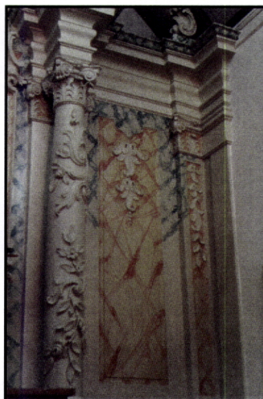
Fig. 12 -Madeira com preparada com litopone e pronta a levar o “banho” para posterior execução do fingido.
