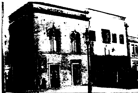
Fig. 2.9. Edifício dos Paços do Concelho antes da sua demolição (CME)
