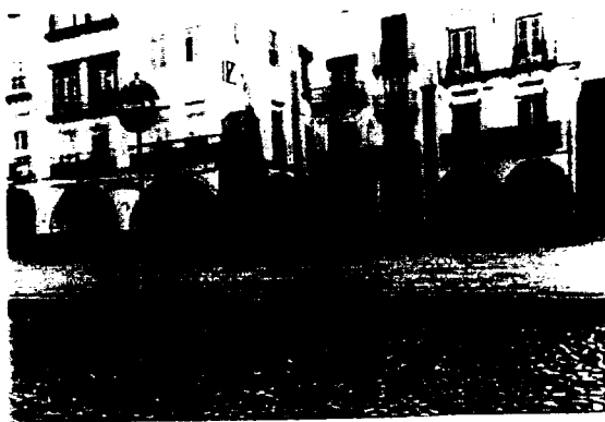
Fig. 2.7. Lado Nascente da praça, onde se pode verificar o desalinhamento dos edifícios. (CME)
