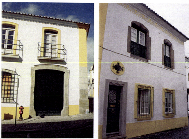
Fig. 4.1 e Fig. 4.2. Edifícios do centro histórico de Évora, onde o ocre substitui possíveis rebocos de simulação de pedra
