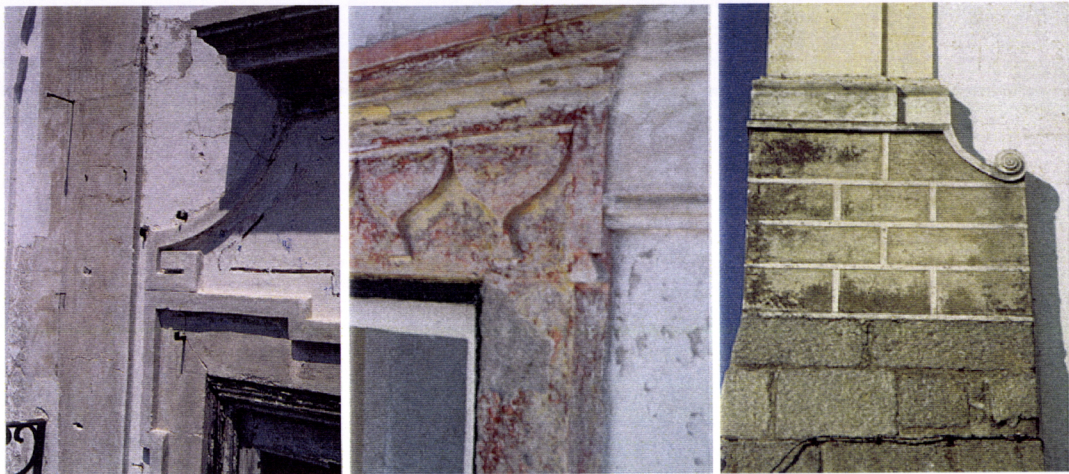
Fig. 4.21, Fig. 4.22 e Fig. 4.23. Rebocos de simulação de pedra na Praça do Giraldo
