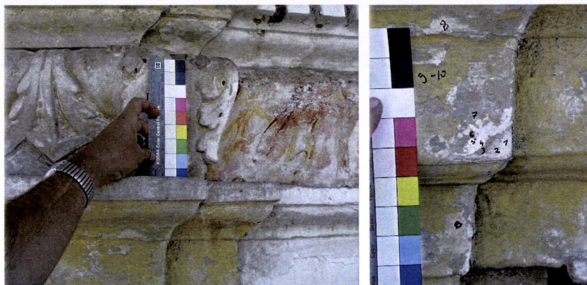
Fig. 4.27 e Fig. 4.28. Pormenores da comija e pilastra da Sociedade Harmonia Eborense (Fotos de José Aguiar)
