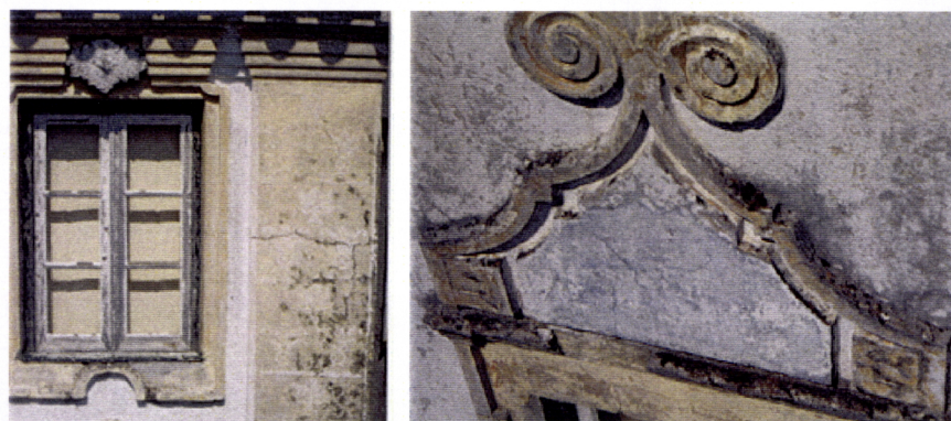
Fig. 4.10 e Fig. 4.11. Fingidos de pedra em edifício da Rua 5 de Outubro (próximo da Praça do Giraldo)
