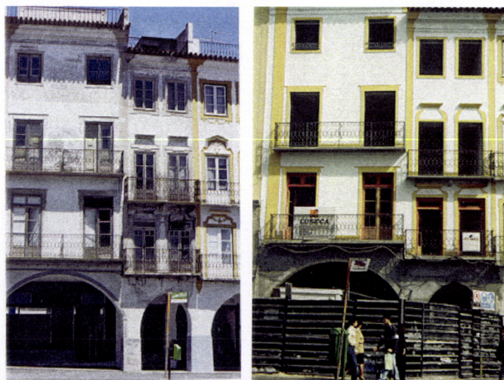
Fig. 4.35 e Fig. 4.36. Edifícios antes e depois da intervenção realizada (em conclusão)
