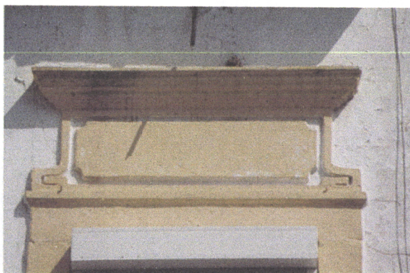
Pormenor do vão do 2º piso
