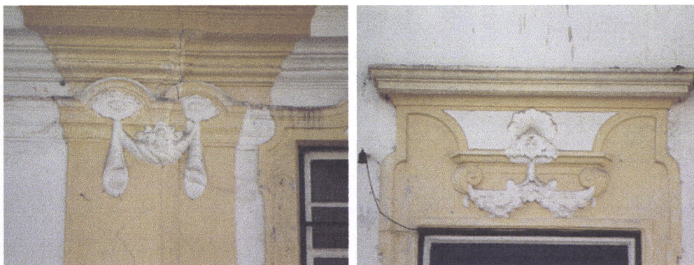
Pormenores da pilastra e do vão do 2º piso
