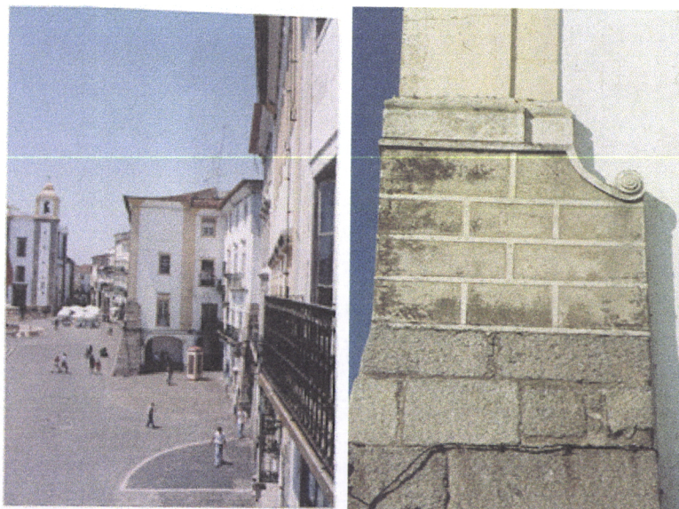
Vista sul do edifício e pormenor do fingido de pedra.
