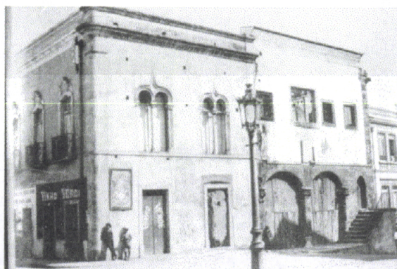
Edifício dos Paços do Concelho, demolido no início deste século (CME)
