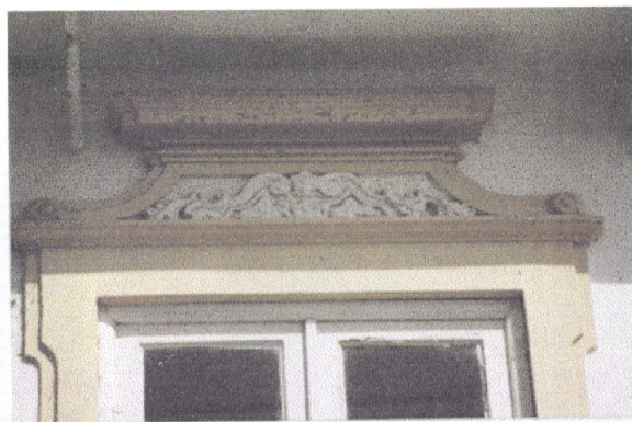
Pormenor do vão do 2º piso
