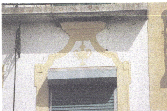
Pormenor do vão do 2º piso
