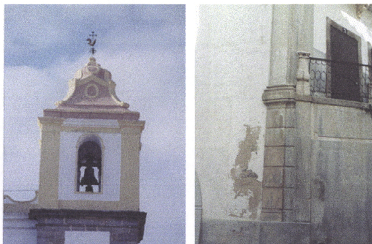
Pormenor da torre e da fachada para a Rua Serpa Pinto (com guarnecimento de simulação de pedra)
