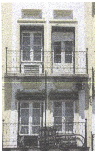
Pormenor dos vãos dos 2º e 3º pisos.
