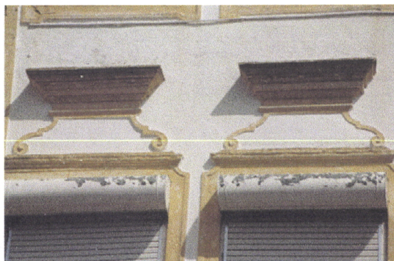
Pormenor do vão do 3º piso.
