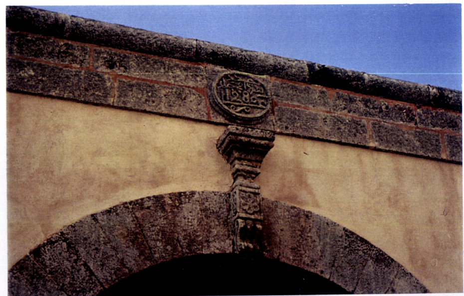
FOTO 003 Baluarte de São Sebastião - Agosto de 1999. Podemos aqui encontrar a sobreposição clara de duas fases distintas de construção. Sobre a construção original do séc. XVI foi edificado um corpo com diferente tipologia e modo de construção.
