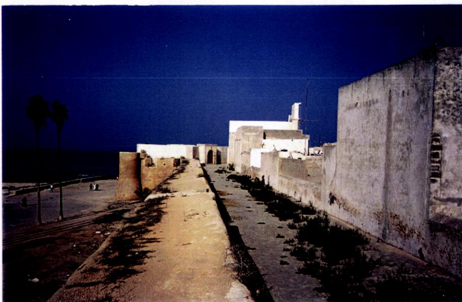
FOTO 024 Fachada Norte – Agosto de 1999. De notar a grande espessura do parapeito, característica do período da fortificação de transição.
