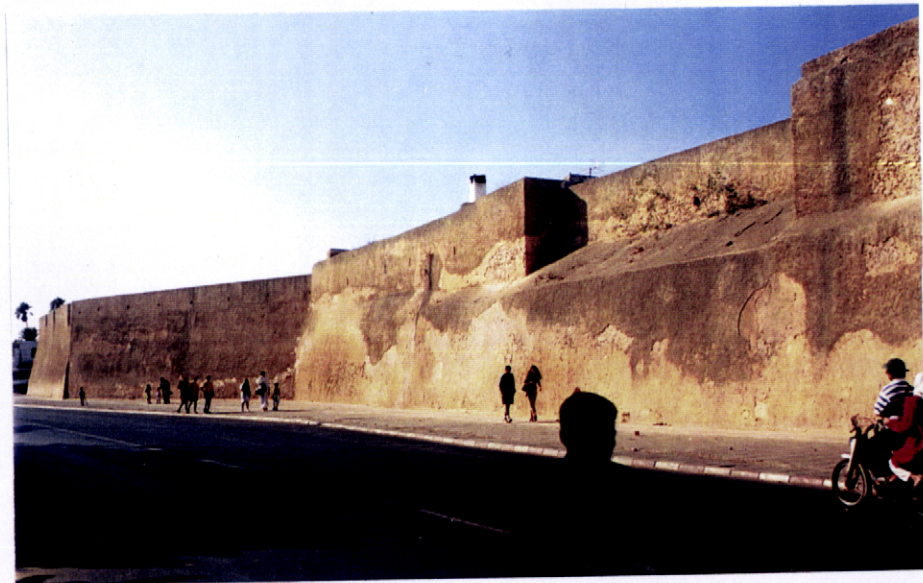
FOTO 017 Fachada Poente / terrestre – Agosto de 1999. Sobre a ruína da fortificação original foram construídos novos muros que conferiram ao conjunto uma altura constante. Desapareceu o Baluarte do Governador e foram suprimidos os flancos dos Baluartes de Santo António e do Santo Espírito, ficando as suas faces integradas na cortina. No lado interior desta estrutura, desapareceu o reparo e um conjunto de edifícios passou a estar encostado aos muros que constituem hoje a cortina. O fosso foi atulhado, foram abertas três novas portas e, já nos anos oitenta do séc. XX, foi aplicado um reboco que confere a homogeneidade possível ao conjunto.
