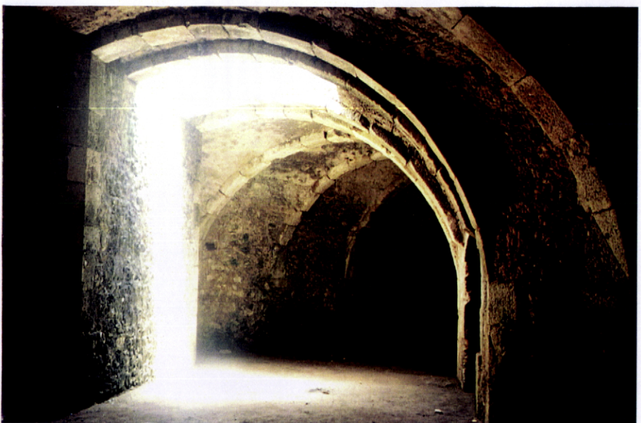
FOTO 050 Interior do Baluarte de Santo António – Agosto de 1999. O interior do baluarte aparenta não ter sofrido alterações significativas em relação à sua estrutura original. Possui duas casamatas com canhoneiras voltadas sobre os flancos, ligadas entre si e com acesso desde o interior da fortaleza através de um corredor. Existe igualmente uma ligação à Porta da traição. Toda esta estrutura encontra-se hoje em relativo bom estado de conservação.
