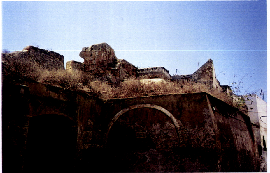
FOTO 039 Vestígios do Baluarte do Governador – Agosto de 1999. Este baluarte localizava-se a meio da fachada Poente / terrestre e era através do seu interior que se realizava a entrada na fortaleza do lado terra. O baluarte terá sido minado e completamente destruído pelos portugueses quando da sua retirada em 1769. Os vestígios que hoje podemos encontrar são insuficientes para identificar a sua estrutura base.
