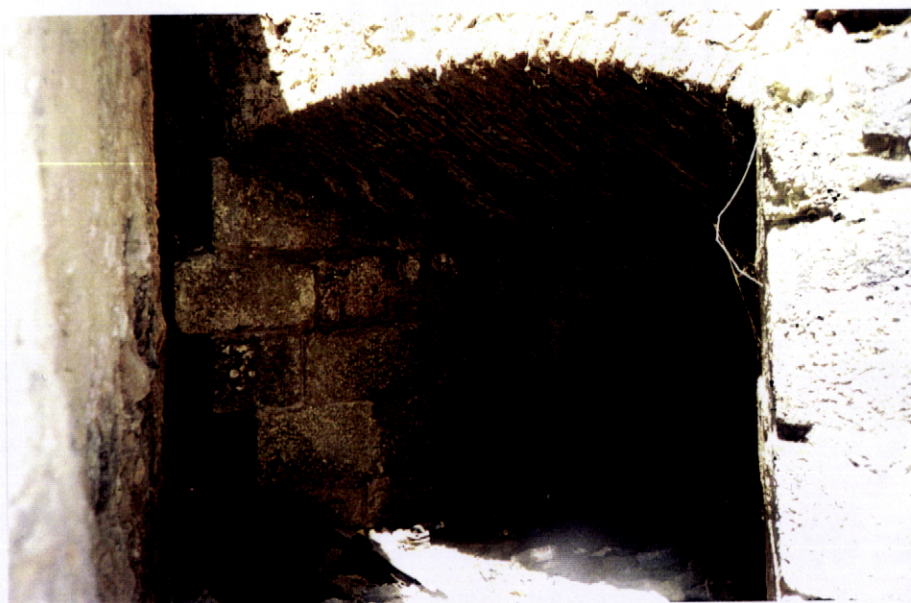
FOTO 111 Canhoneira inferior do Baluarte de Santo António voltada a Sul – Agosto de 1999. Frente à antiga canhoneira foi construído um muro, correspondente à nova face do baluarte, no seguimento da cortina. Deste modo, foi eliminado o flanco do baluarte.
