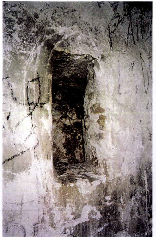
FOTO 074 Construções sobre o Baluarte do Anjo – Agosto de 1999. Construção correspondente ao paiol. Podemos ainda hoje observar a existência de orifícios em z na parede, destinados à renovação do ar. O armazenamento da pólvora exigia um lugar próprio que deveria possuir bom arejamento, para a conservação, em boas condições, do explosivo. A execução do sistema de ventilação exigia soluções que impedissem simultaneamente a entrada de qualquer objecto.
