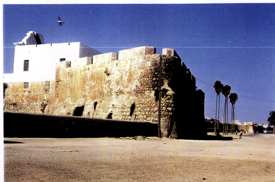
FOTO 053 Baluarte de São Sebastião – Agosto de 1999. Flanco voltado para o Baluarte de Santo António, incluindo orelhão curvo com torreta e canhoneira inferior.
