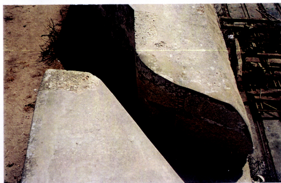
FOTO 099 Canhoneira situada no Baluarte de Santo António – Agosto de 1999. Canhoneira do tipo A, com um parapeito largo e merlão de perfil arredondado, inclinado para o exterior. Este é um perfil que corresponde a um modelo típico de fortificação de transição. Estas canhoneiras, construídas em pedra calcária, são certamente canhoneiras originais construídas no séc. XVI.
