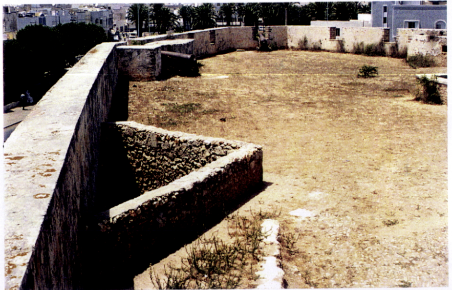
FOTO 109 Canhoneira situada no Baluarte de Santo António – Agosto de 1999. Vestígio do antigo parapeito com maior espessura e canhoneira do tipo A. Este troço é um vestígio da antiga face do baluarte. Esta face foi reconstruída com diferente traçado em planta e parapeito de espessura inferior onde se incluíram novas canhoneiras do tipo B.
