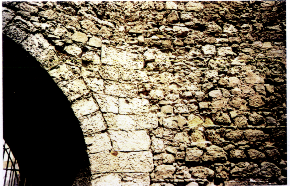
FOTO 159 Alvenarias de pedra na zona da calheta na fachada Nascente/marítima – Setembro de 2000. É obvia a diferença de resistência entre as zonas que possuem alvenaria de pedra aparelhada com juntas bem definidas e as que possuem alvenarias irregulares, com juntas de maiores dimensões. Enquanto nas primeiras a pedra apresenta alguma protecção contra os agentes externos, nas segundas tanto a pedra como a argamassa das juntas se encontram completamente desprotegidas. Com a grande quantidade de juntas entre blocos expostas à acção do ambiente envolvente acelera-se o processo de degradação da alvenaria, com a correspondente desagregação do material, o que se vai reflectir na existência de juntas muito abertas e no aparecimento de lacunas.
