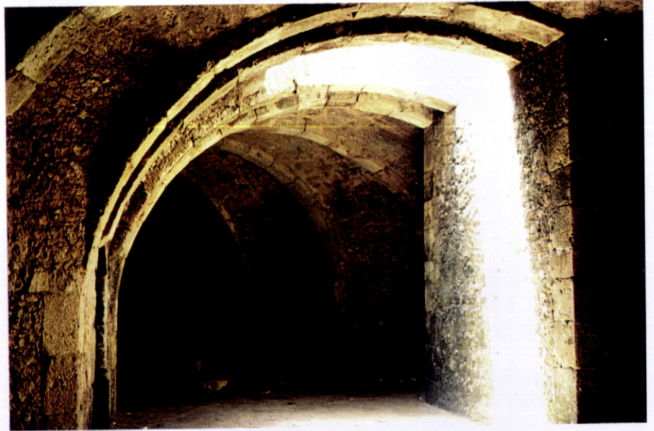
FOTO 144 Acesso às casamatas do Baluarte de Santo António – Agosto de 1999. Paredes em alvenaria de pedra irregular e abóbada em tijolo reforçada por arcos em pedra aparelhada. Pavimento em terra batida.
