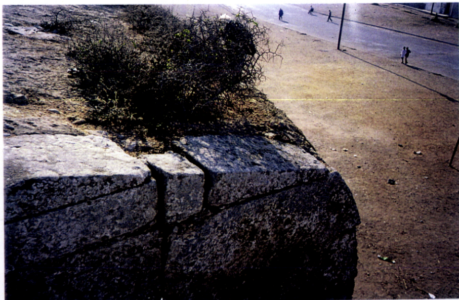
FOTO 164 Porta da Ribeira – Setembro de 2000. Lacuna de elementos de pedra aparelhada na cantaria.
