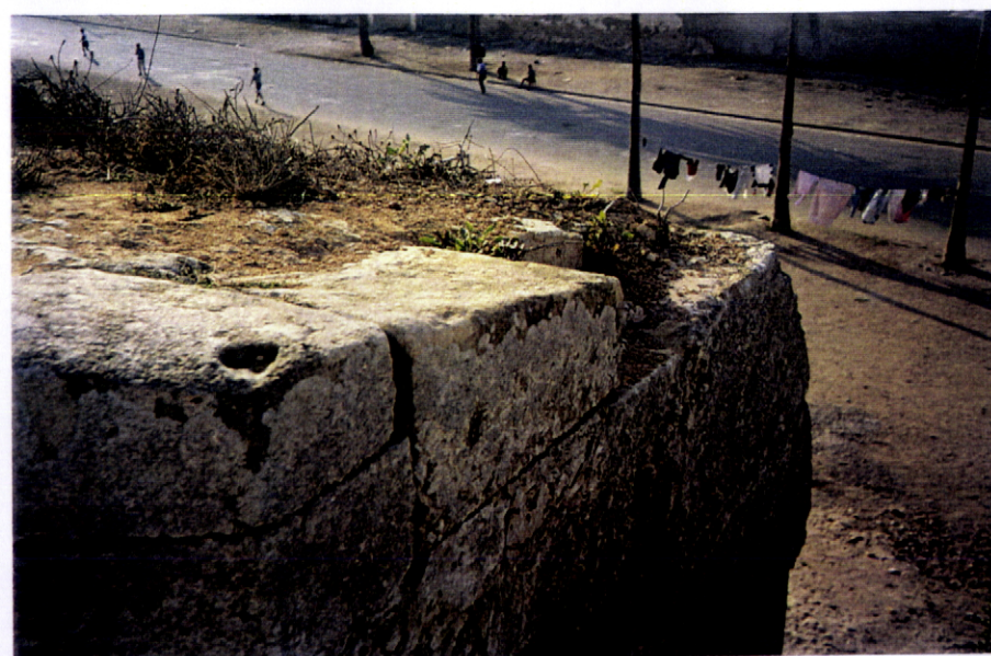
FOTO 167 Canhoneira na cortina Norte – Setembro de 2000. Verifica-se a existência de numerosas lacunas de elementos de pedra aparelhada em canhoneiras. Esta degradação deve-se aparentemente a acções de vandalismo. O acelerar deste tipo de degradação deve ser travado com urgência, tanto mais que ele corresponde à degradação de elementos que consideramos pertencentes à fortificação original.
