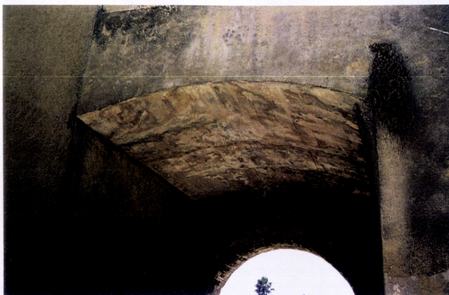
FOTO 146 Baluarte de Santo António – Agosto de 1999. Arco de porta em pedra aparelhada e abóbada em tijolo.
