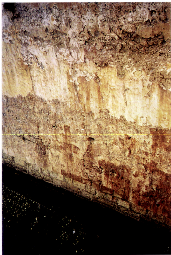
FOTO 149 Argamassas de revestimento no Baluarte do Anjo – Setembro de 2000. Os rebocos do tipo A revelam boa coesão, embora apresentem muitos orifícios e pequenas lacunas.
