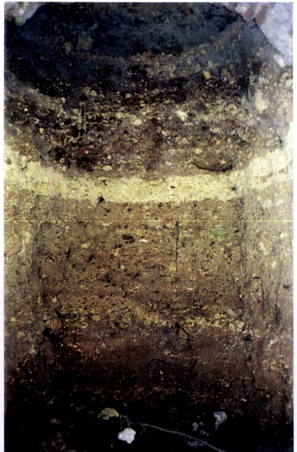
FOTO 137 Abertura existente no interior do Baluarte de Santo António – Setembro de 2000. Podemos observar em corte as diferentes camadas que constituem o material de enchimento do terraplino do baluarte.
