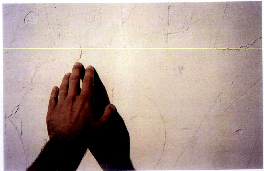
FOTO 156 Argamassas de revestimento no Baluarte do Anjo – Setembro de 2000. Os rebocos do tipo C foram realizados à base de cal branca em pedra, extinta com a areia em traço. Possuem coloração amarelada e um acabamento liso. O facto de serem rebocos muito “macios” torna-os alvo da realização de inscrições. Para além desta forma de degradação, este tipo de reboco parece adequado à fortificação, enquadrando-se bem no conjunto.
