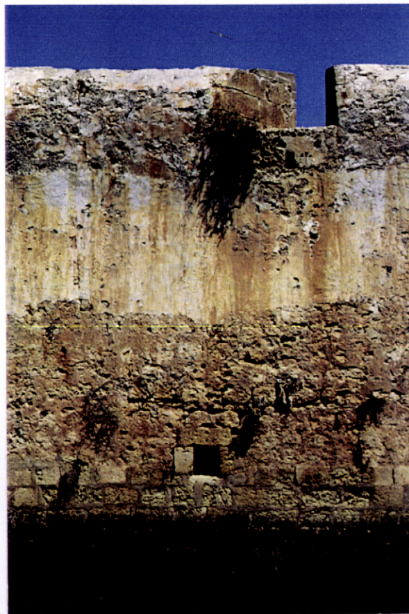
FOTO 149 Argamassas de revestimento no Baluarte do Anjo – Setembro de 2000. Os rebocos do tipo A revelam boa coesão, embora apresentem muitos orifícios e pequenas lacunas.
