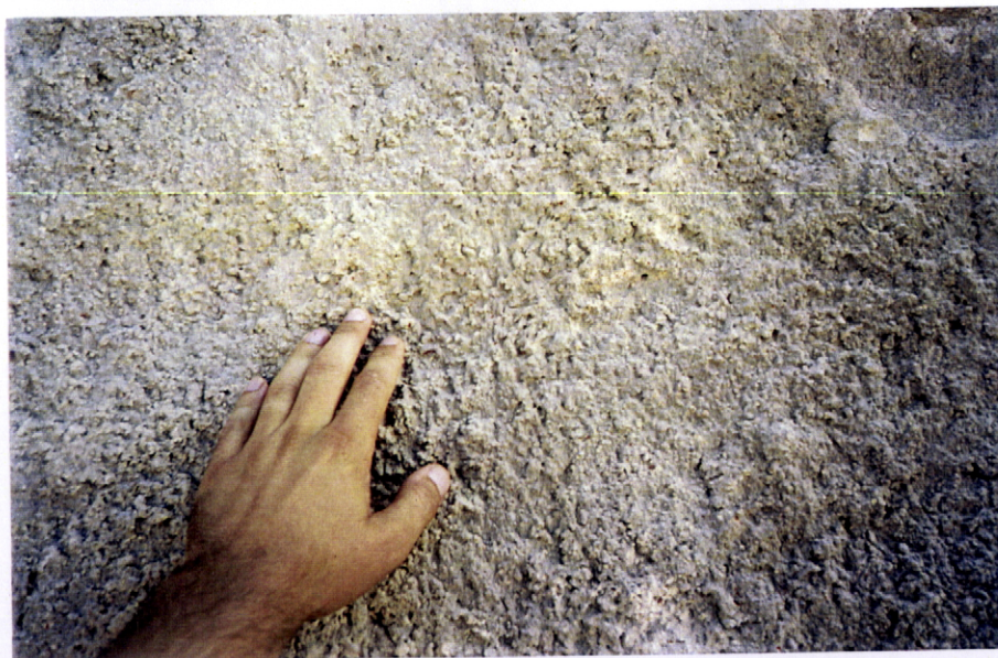
FOTO 153 Argamassas de revestimento na Cortina Poente/terrestre – Setembro de 2000. Os rebocos do tipo B são bastante duros e caracterizados pelo seu acabamento rugoso. A rigidez aparente destes rebocos leva-nos a suspeitar da existência de cimento na sua composição. A acumulação de sujidades, a cor e a rugosidade dos rebocos conferem a esta zona da fortificação um aspecto menos cuidado.
