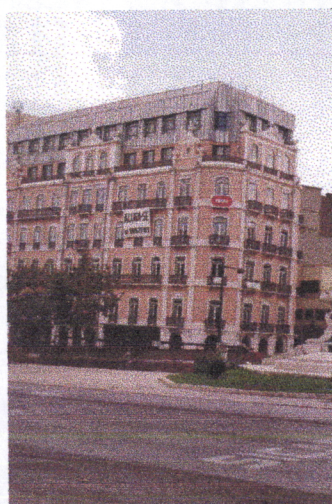
Fig. 89 Edifício de esquina. Avenida da Liberdade, n.º 133 a 153.
