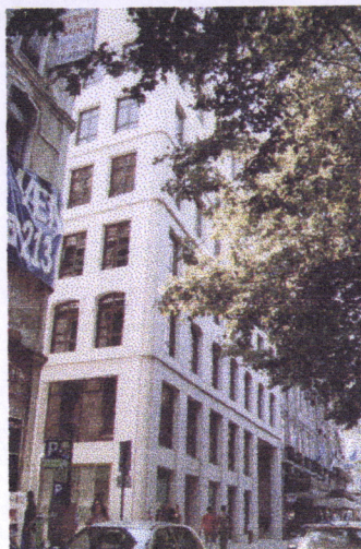
Fig. 87 Imóvel sito na Avenida da Liberdade, n.º 69.
