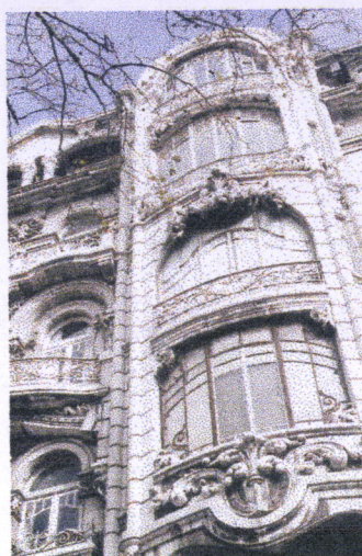
Fig. 81 Edifício Visconde de Salreu. Avenida da Liberdade, n.º 206 a 218.
