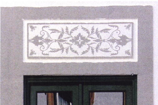
Figura 135 - Esgrafito após intervenção inadequada - Rua 5 de Outubro, 44
