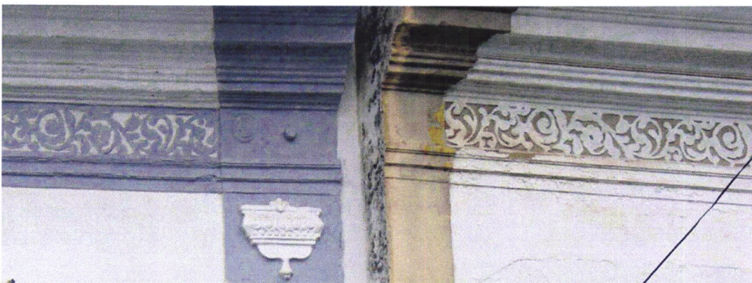
Figura 133 - O mesmo esgrafito pintado com inversão do efeito claro-escuro no lado esquerdo - Rua de Avis e na Travessa do Fragoso
