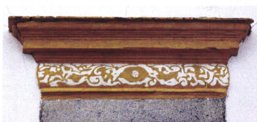
Figura 131 - Pinturas sucessivas sobre esgrafito - Rua Vasco da Gama, 18
