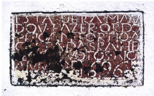
Figura 108 - Esgrafito com fundo de argamassada de coloração vermelha - Igreja de Benavila, Avis
