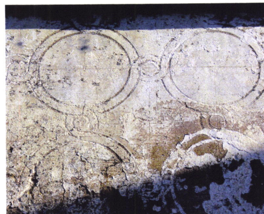
Figura 047 - Pormenor da porta de entrada do Convento de N. S. da Assunção do Castelo, Moura
