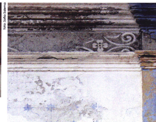
Figura 137 - Rua das Fontes, 41
