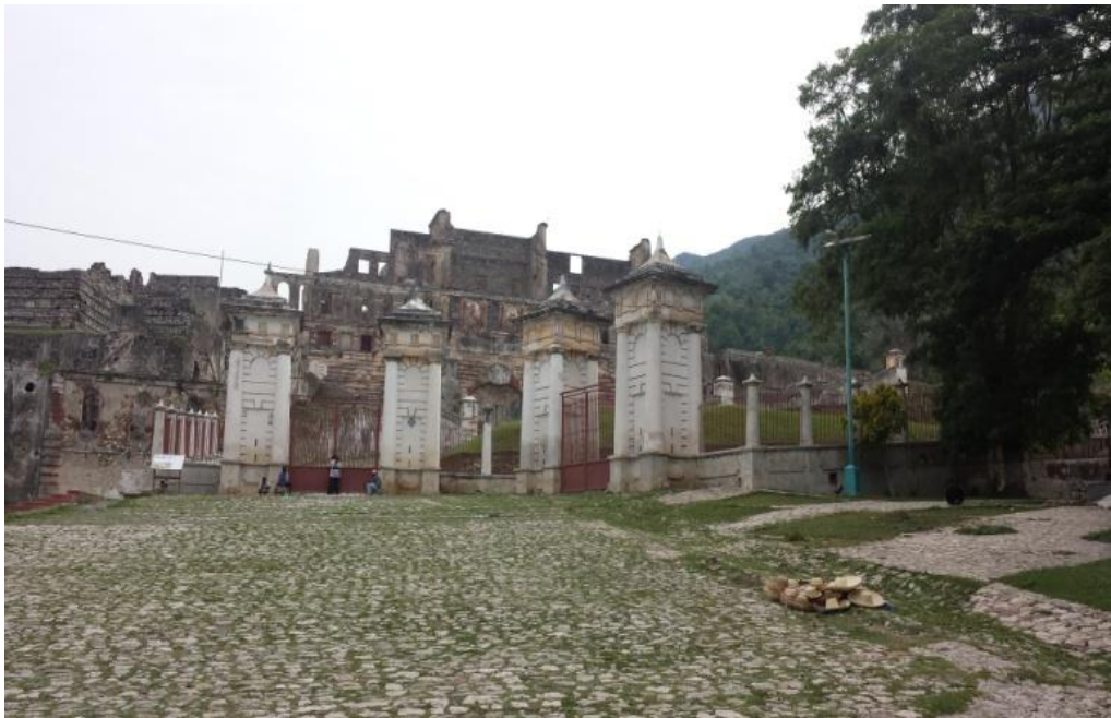
Le Palais Sans Souci après le tremblement de terre de 1842 Source : Auteur, photo prise le 24 Juillet 2014 à Milot
