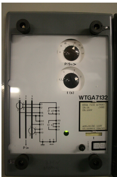
Figura 18 – Protecção WTGA 7132 (subpotência)
