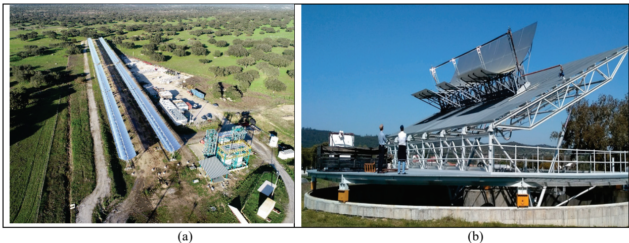
Fig. 4. Plataformas de ensaio na Herdade da Mitra da Universidade de Évora. (a) Plataforma de sais fundidos (EMSP); (b) Plataforma de ensaio de concentradores solares (PECS).
