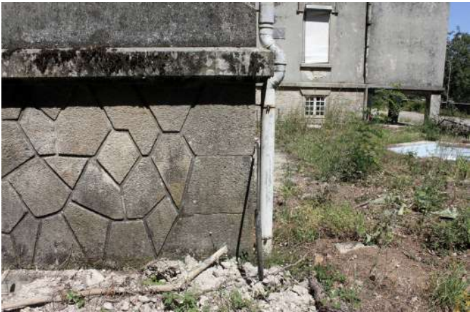
Figura 134. Estereotomia Lambrim Exterior
