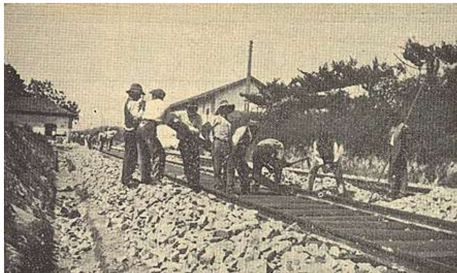
Figura 46. Assentamento de via na Linha do Minho
