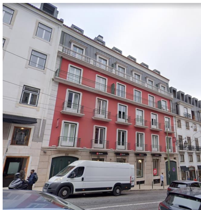
Figura 5 – Fotografia da fachada para a Rua da Misericórdia. Fonte: GoogleMaps (Consultado a 4 de julho de 2023)
