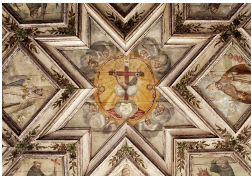
Figura 6 – Pormenor do teto da galilé do Convento de Santo Antônio de Igarassu (Pernambuco). Elaborado pelo autor.
