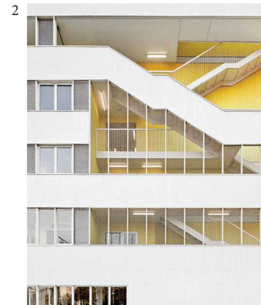
Figura 40: Fachada del edificio.
