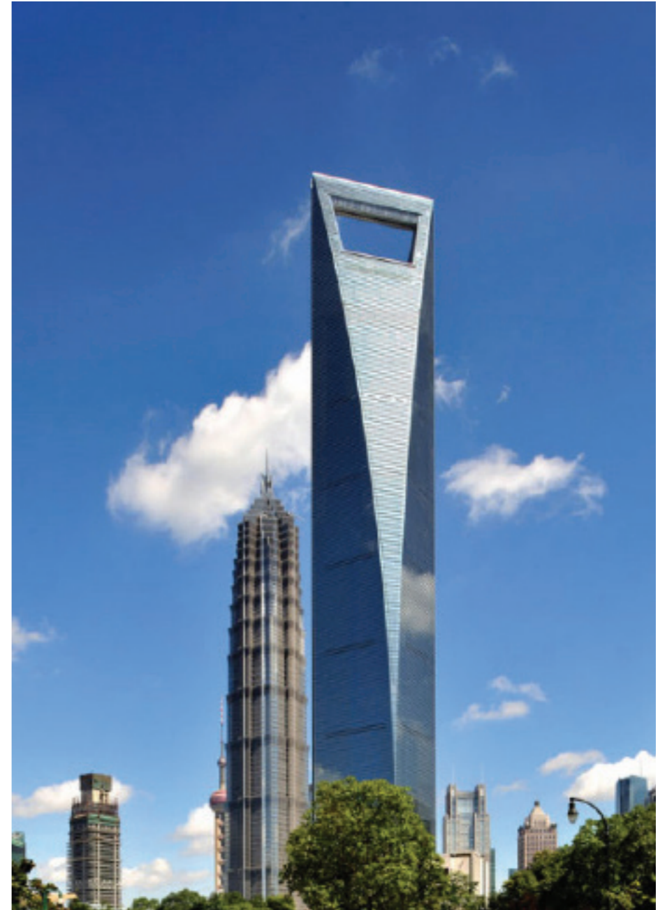
Figura 72: Vista exterior del edificio. Fuente: Obtenida de https://s3.amazonaws.com/images.skyscrapercenter.com/thumbs/21397_500x650.jpg .
