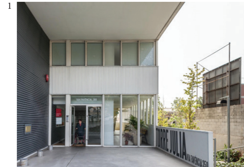
Figura 39: Entrada principal al edificio.
