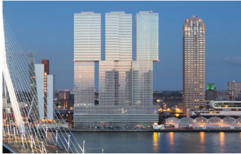
Figura 90: Edificio De Rotterdam en proceso de construcción. Fuente: Obtenido de https://aplust.net/blog/oma_de_rotterdam_en_construccion_paises_bajos/ .
