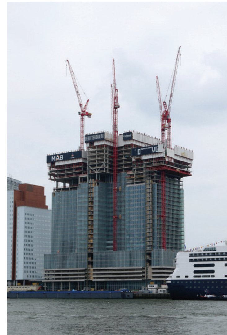
Figura 89: Edificio De Rotterdam en proceso de construcción.
