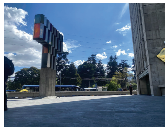
Figura 98: Entrada al edificio COFIEC. Fuente: Foto tomada por la autora.
