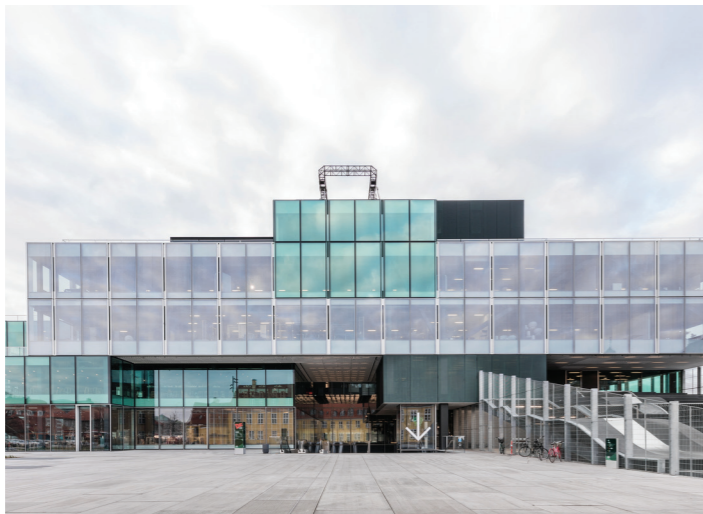
Figura 47: Alzado e ingreso frontal del edificio. Fuente: https://images.adsttc.com/media/images/5af0/511b/f197/cc67/b100/0605/slideshow/BLOX_-_Delfino_Sisto_Legnani_and_Marco_Cappelletti_-_9.jpg?1525698805 .
