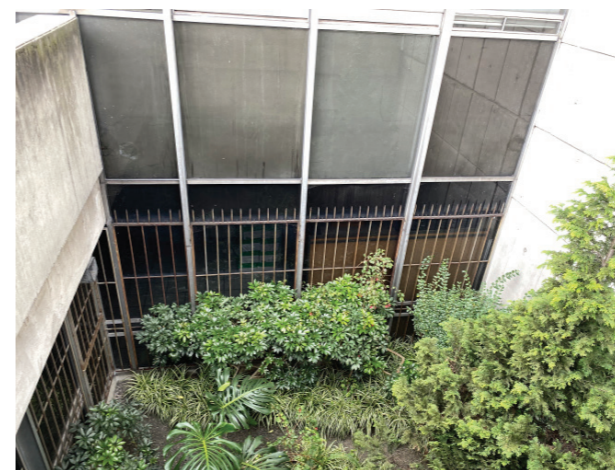
Figura 104: Patio interno del edificio COFIEC. Fuente: Foto tomada por la autora.
