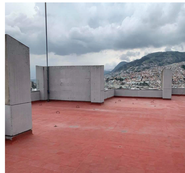
Figura 168: Foto de la terraza actual del edificio cofiec. Fuente: Foto tomada por la autora.
