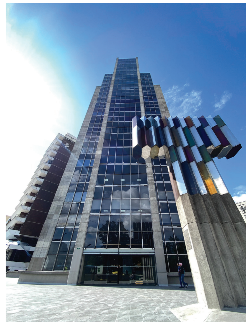
Figura 94: Alzado frontal del edificio COFIEC. Fuente: Foto tomada por la autora.
