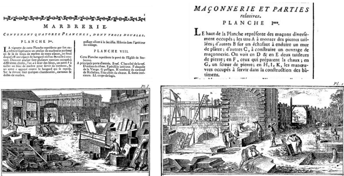
Figure 21 . A gauche : atelier de transformation des blocs de marbre. A droite : chantier de construction (Source : L'encyclopédie de Diderot et D'Alembert )
