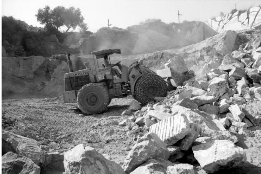
Figure 30 : Tracteur enlevant les blocs de marbre, carrière Viana do Alentejo, XXème siècle (source : archives CECHAP, P0352)
