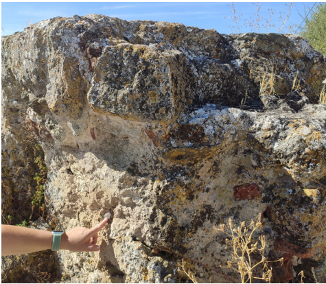
Fig. 031. Pedra mal aparelhada, argamassada na Zona 2. Zona identificada na fig.029.
