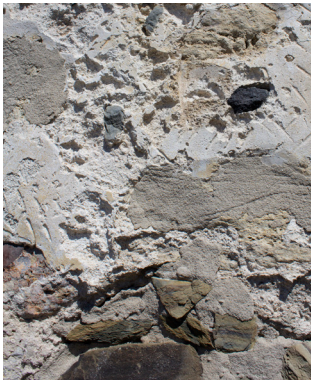
Fig. 041. Argamassa de revestimento numa das zonas previamente reparada.
