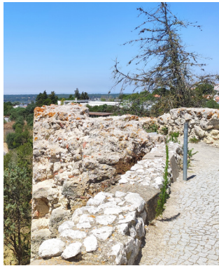
Fig. 039. Ausência de capeamento.
