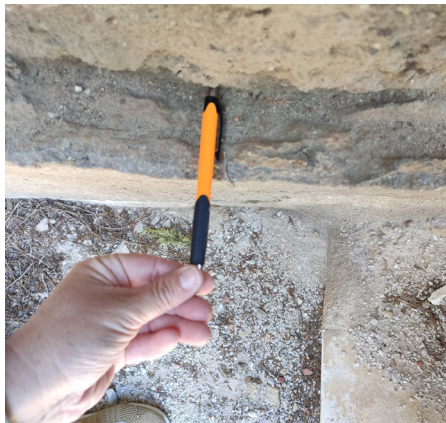
Fig. 045. Espessura de 50mm da camada de reboco. Local de recolha da amostra ALC11E/I.
