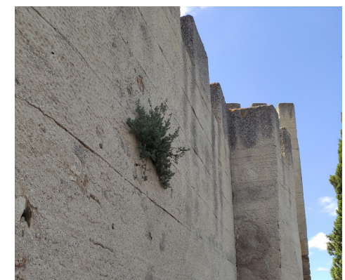
Fig. 055. Presença de vegetação nos paramentos verticais.
