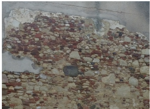
Fig. 051. Reconstrução com alvenaria de tijolo e pedra.
