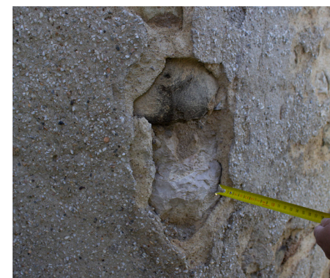
Fig. 054. Espessura de 25mm da camada de reboco. Local de recolha da amostra ALC9.
