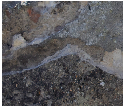
Fig. 030. Camadas de reboco, identificação de zona de recolha das amostras ALC 5 e ALC 4E.
