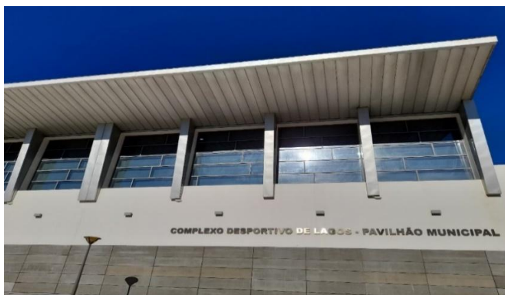
FIGURA 10: COMPLEXO DESPORTIVO DE LAGOS- PAVILHÃO MUNICIPAL
