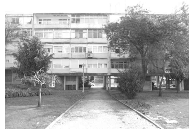
23. A utilização dos pilotis , permitindo a libertação do piso térreo e a facilidade de circulação, é um dos vários elementos do movimento modernista presentes no bairro.
