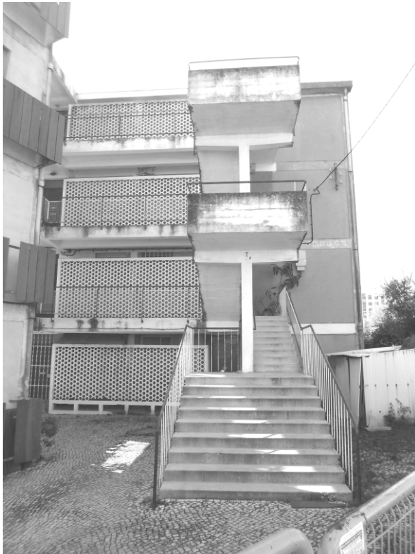
34. Pormenor da escadaria de acesso aos três pisos superiores e articulação com as galerias exteriores.
