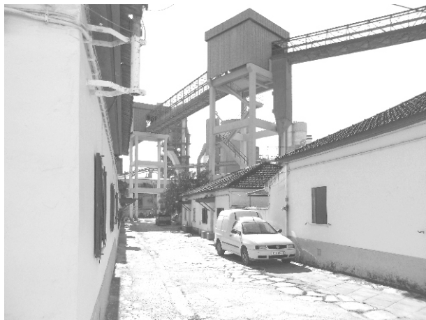
28. Tapete mecânico superior que em meados do século substituiu o transposte via vagonetas e obrigou a alterações no bairro.
