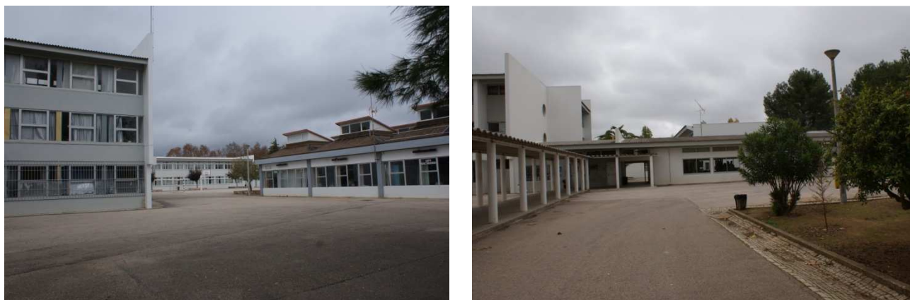
Figura 6 – Pavimento betuminoso e valetas de drenagem em calçada de calcário branco.
