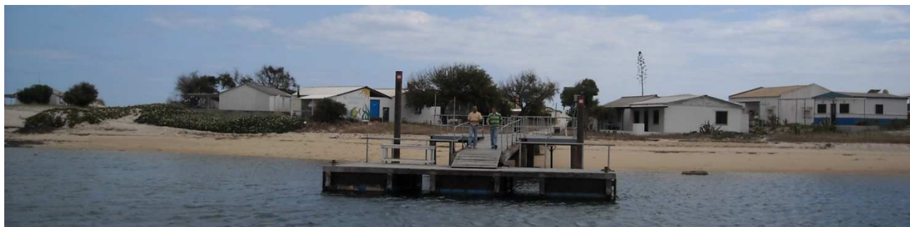
Figura 41 – Ancoradouro existente na Ilha da Fuzeta, destruído pelos fortes temporais
