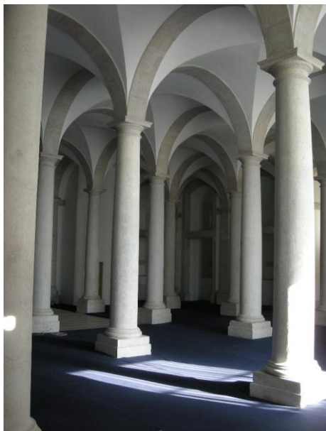
Fig. 13 – Vista da sala do piso térreo do torreão poente. Chama-se a atenção para a solução de arcaria e conjugação de fenestração à frente da janela que permite iluminar o espaço e que é exactamente igual ao que se encontra no claustro do pátio da Galé. Foto do autor.
