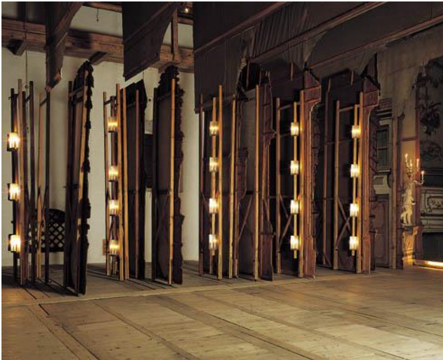
Fig. 303 – Iluminação de bastidores no teatro do castelo de Krumlov. Chama-se a atenção também, para a marcação dos carretes no chão, de forma a ser possível a movimentação dos cenários com mais facilidade.
