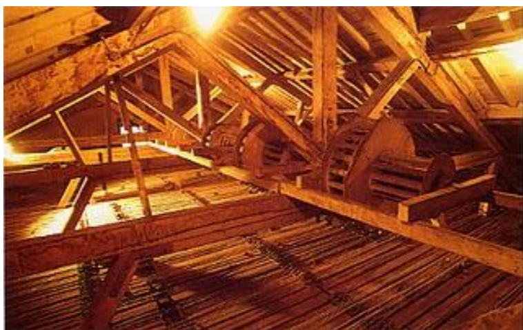
Fig. 311 – O tambor e a maquinaria que se encontra na parte do tecto do S. Carlos. Apesar de já não estar em funcionamento, mantém toda a estrutura original setecentista. Actualmente está pintada com uma tinta branca que ajuda a evitar incêndios. Foto consultada em http://www.google.pt/imgres?um=1&hl=pt-PT&biw=1311&bih=540&tbn=isch&tbnid=GehQgh6549u1CM:&imgrefurl=http://pap-na-eptc.blogspot.com/2008/02/o-real-teatro-de-s-carlos-em-lisboa.html&docid=h6MBsloa4ys-IM&imgurl=http://3.bp.blogspot.com/_-8N8Kl5wH4s/R7Ihwj7otCI/AAAAAAAAABdQ/YYy2FqRkbEw/s320/teia%252BS.%252BCarlos.JPG&w=320&h=200&ei=n-vkT_7IGIu7hAfD5ODWCQ&zoom=1 a 11 de Agosto de 2011.
