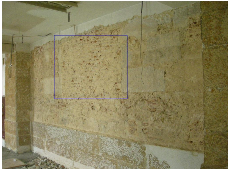
Fig. 82 – Pormenor da base do pilar junto ao topo da sala térrea do Cofre da Providência. Os materiais construtivos são, para além da pedra, cascalho, tijolo e areia, rebocados e caiados.
