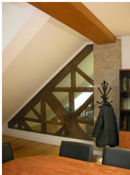
Figs. 118 e 119 – Imagens da cobertura da Academia da Marinha (3º e último andar). Vestígios da solução da gaiola pombalina em madeira do século XVIII, provavelmente do tempo da reconstrução, em 1758-59.
