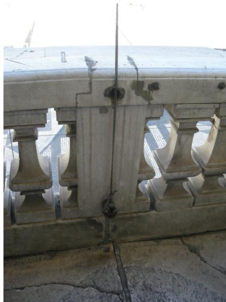
Balastrada do varandim Norte do Tribunal da Relação. Vejam-se os remendos feitos na pedra para como na balastrada, os blocos de pedra bons. Lembremo-nos que, a ser este
