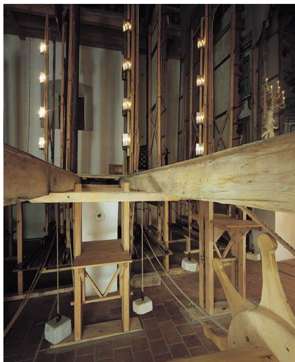
Figs. 310a e 310b – Roldanas, bambolinas, tambores, teia e bastidores móveis a partir do subpalco, que serviam, entre outras coisas, para ajudar nas movimentações dos barcos e outros acessórios cénicos. Teatro de Krumlov, República Checa, original do século XVIII. Na segunda imagem vemos a possibilidade de abrir o palco para o melhor encaixe dos barcos, havendo uma ligação entre o subpalco e o palco. Esta solução também poderia ajudar a fazer surgir e desaparecer personagens a partir do subpalco, através de elevadores, controlados também com pesos e contrapesos (alguns exemplificados na figura da direita).
