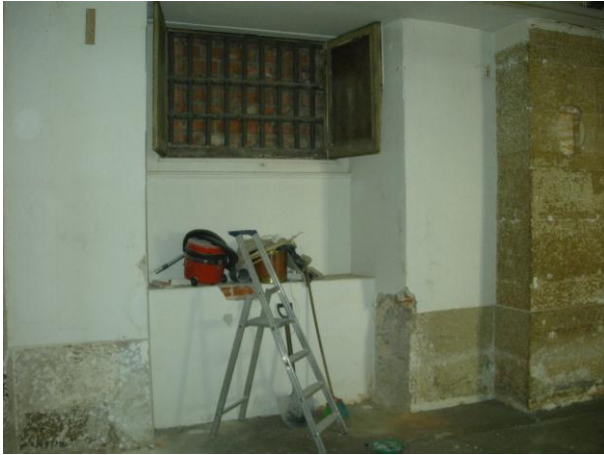
Fig. 80 – Obras na parede Sul do Cofre da Providência que deixaram à vista uma janela setecentista, com as grades originais e que fora entaipada posteriormente.
