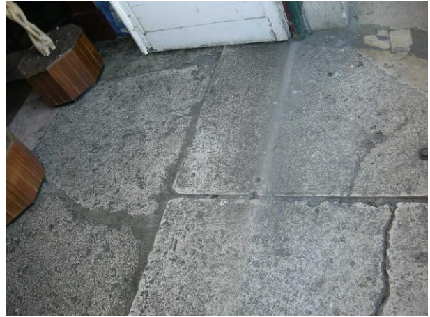
Fig. 111 – Pedras que constituem o chão do varandim Norte do Tribunal da Relação e que fazem a transição entre a sala de entrada e o varandim. Colocamos em hipótese que terão estas pedras sido submetidas pelo fogo que grassou a Ópera do Tejo, depois do Terramoto e subsequente maremoto, e que acabaram por ser reaproveitadas no edifício que hoje lá se encontra.
