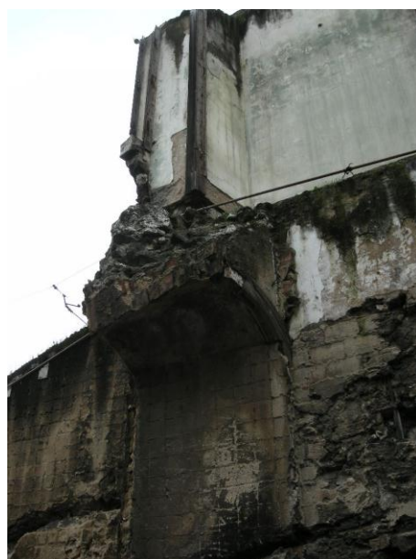
Figs. 147 e 148 – Interior das ruínas da cozinha da Real Barraca I. Pormenor do arco. Destaque para os materiais utilizados: tijolo, cascalho, madeira, revestimento de reboco e azulejo datável de meados do século XVIII. Infelizmente, devido ao vandalismo, muitos azulejos, que ainda se encontravam in situ há cerca de 5 anos atrás, foram roubados e desapareceram. Fotos do autor (2009).
