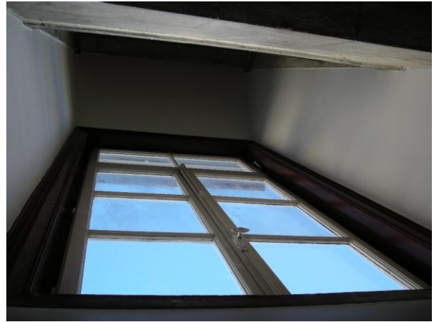
Fig.s 104 e 105 – Nestas imagens poderemos ver a solução encontrada para aproveitar uma janela exterior grande (imagem da direita), embora se corte parte da sua luz colocando-se um piso ao meio da janela (imagem da esquerda)
