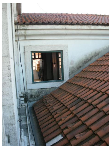
Figs. 19 e 20 – Pormenor do remate e a sua implantação. Acrescente-se o pormenor ao fundo, à direita, da janela situada exactamente na zona de transição entre o edifício e o torreão, onde encontramos a abertura com o remate em forntão triangular entaipado pelo tecto falso (figs.14, 15 e 16). Janela essa que é ligeiramente cortada, no canto inferior direito, pelo telhado de 2 águas do braço poente da Praça do Comércio.
