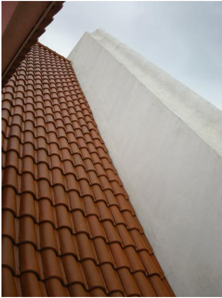
Figs. 121 e 122 – Pormenores do maior guarda-fogo do edifício do Arsenal da Marinha, mostrando o seu remate triangular e o seu recorte a Sul. Pormenor do guarda-fogo principal, que não é o arco do proscénio, mas do poscénio, correspondente ao arco que marca o fim do palco visível ao espectador.
