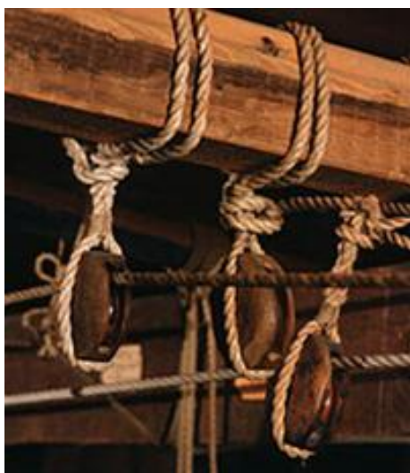
Fig.. 308 – Roldanas no teatro de Krumlov, para ajudar a correr os fios que puxavam os bastidores. República Checa, século XVIII. Comparar com as roldanas, em madeira, ainda existentes na teia do S. Carlos.
