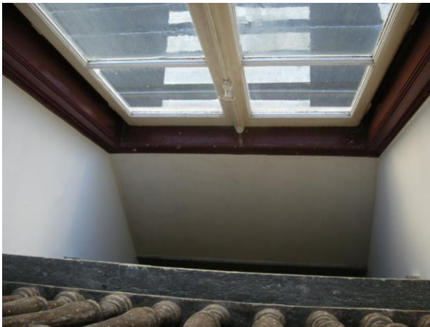
Fig. 106 – Vista do segundo andar, que recebe uma parca iluminação a partir de metade da janela exterior, cuja parte inferior serve para iluminar o primeiro andar. De notar a insensatez da solução, partindo do pressuposto que terá sido um edifício construído de raiz, mas que já faria sentido se de um reaproveitamento se tratasse.
