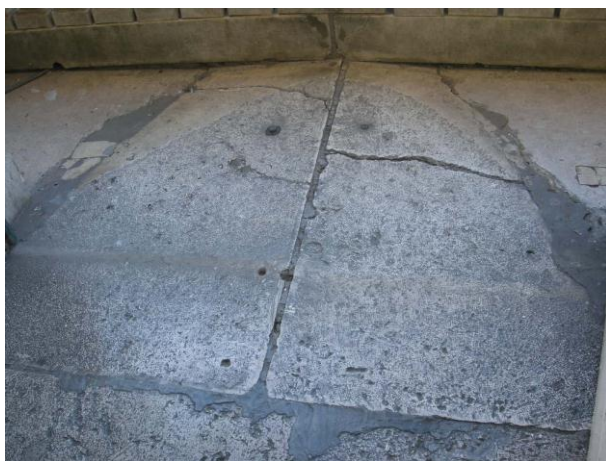
Fig. 109 – No varandim que dá para a Praça do Município, poderemos perfeitamente distinguir uma zona em que a pedra é mais escura, com algumas irregularidades mas que, mesmo assim, foram-lhe anexadas partes de pedra polida, através de gatos e de parafusos, reforçados mais recentemente por uma massa cimentada. Essas pedras centrais de cor pardacenta apresentam sinais típicos de pedras que tenham sido submetidas à acção do fogo.
