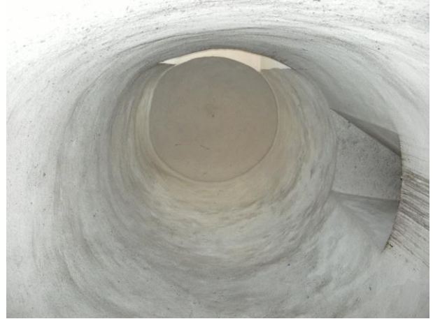
Figs. 70 e 71 – Pormenor do bloco trapezoidal no interior do ginásio do Arsenal da Marinha e que, pese embora as arestas exteriores, é circular no seu interior. Repare-se nas duas aberturas, colocadas a dois níveis, como se de dois pisos se tratasse. O seu interior, circular, não tem qualquer ligação entre os dois níveis, sugerindo uma estrutura que albergou, outrora, uma escadaria em caracol, iluminada pelas duas frestas que ainda são visíveis tanto no interior, como no exterior do edifício (figs. 72 e 73).
