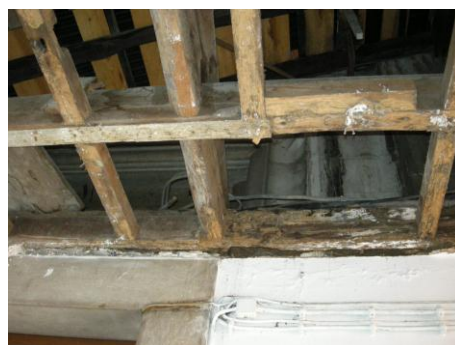
Figs. 14 e 15 – Pormenores da cobertura junto ao torreão poente, no último piso. Consegue-se ver parte do acabamento de uma janela da fachada norte do torreão que ficou tapada pela união entre o edifício e o dito torreão. Veja-se na segunda imagem a parte superior da porta que dá acesso ao 3º andar do torreão, e que não tem correspondência com a abertura que fora tapada pelo tecto falso, agora visível pelas obras. Fotos do autor.
