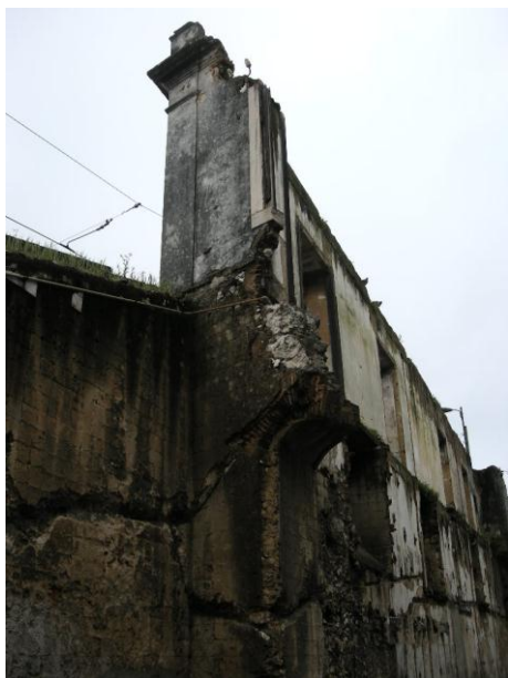
Figs. 147 e 148 – Interior das ruínas da cozinha da Real Barraca I. Pormenor do arco. Destaque para os materiais utilizados: tijolo, cascalho, madeira, revestimento de reboco e azulejo datável de meados do século XVIII. Infelizmente, devido ao vandalismo, muitos azulejos, que ainda se encontravam in situ há cerca de 5 anos atrás, foram roubados e desapareceram. Fotos do autor (2009).
