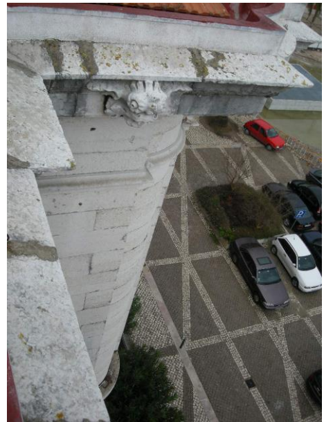
Figs. 91 e 92 – Pormenores da terminação do guarda-fogo, anteriormente arco do fundo de cena do teatro de Lisboa, e o seu apoio na esquina sul do Arsenal da Marinha.
