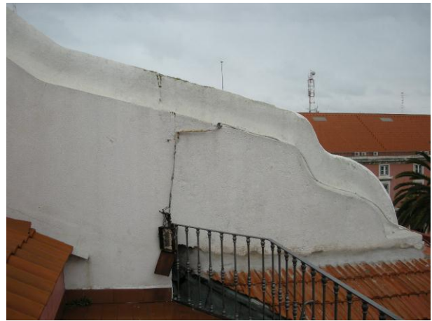
Figs. 121 e 122 – Pormenores do maior guarda-fogo do edifício do Arsenal da Marinha, mostrando o seu remate triangular e o seu recorte a Sul. Pormenor do guarda-fogo principal, que não é o arco do proscénio, mas do poscénio, correspondente ao arco que marca o fim do palco visível ao espectador.
