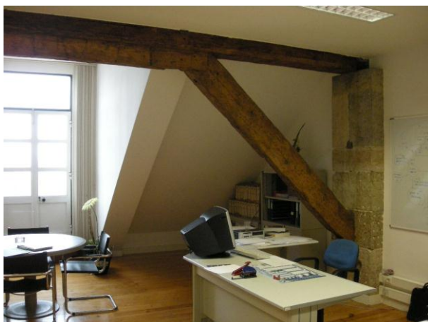
Figs. 118 e 119 – Imagens da cobertura da Academia da Marinha (3º e último andar). Vestígios da solução da gaiola pombalina em madeira do século XVIII, provavelmente do tempo da reconstrução, em 1758-59.
