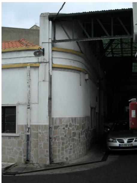
Figs. 154 e 155 – Note-se as semelhanças das curvaturas das esquinas do edifício que se encontra no quartel da Ajuda com aquelas que permanecem na Rua do Arsenal, incluindo os frisos horizontais e, de certa forma, o basamento. Saliente-se o facto de a parede exterior do edifício da Ajuda ser mais alta e não se coadunar estruturalmente com o resto do edifício. Fotos do autor (2009).
