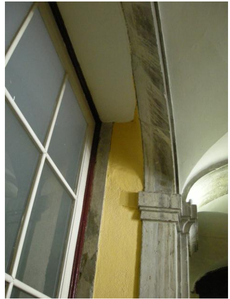
Figs. 100 e 101 – Janela fechada que se encontra na parede Sul do piso térreo do Tribunal da Relação, bloqueada ao meio pela abóbada, não havendo justificação prática, estilística ou arquitectónica para esta solução. Pormenor do remate do arco que a precede e que a tapa, não se compreendendo a sua utilidade no local em questão.
