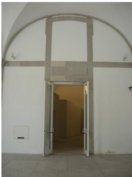
Fig. 30 – Uma das portas que se abrem para o claustro do pátio da Galé, cuja janela que a remata está entaipada, à semelhança do que acontece em quase todos os panos de parede envolventes no dito claustro. Foto do autor.
