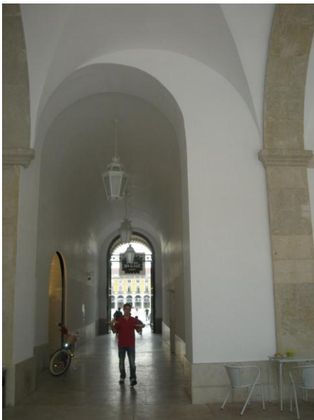
Fig. 34 – Imagem da ligação entre a Praça do Comércio e o Pátio da Galé. Essa ligação não usou de todo o vão formado pelos pilares que sustentam os arcos de volta inteira que permitem a elevação das abóbadas cruzadas do claustro que temos vindo a tratar. Essa abertura foi feita de forma descuidada, visto ter deixado sem apoio a ponta mais a sul do ábaco do pilar de sustentação da esquerda. Terá sido uma abertura que tenha aproveitado um das portas encimadas por um janelão, que vemos em todos os panos de parede do claustro? Fica a questão. Foto do autor.
