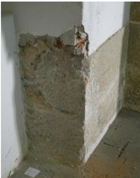
Fig. 82 – Pormenor da base do pilar junto ao topo da sala térrea do Cofre da Providência. Os materiais construtivos são, para além da pedra, cascalho, tijolo e areia, rebocados e caiados.
