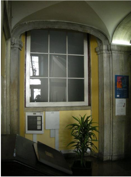
Figs. 100 e 101 – Janela fechada que se encontra na parede Sul do piso térreo do Tribunal da Relação, bloqueada ao meio pela abóbada, não havendo justificação prática, estilística ou arquitectónica para esta solução. Pormenor do remate do arco que a precede e que a tapa, não se compreendendo a sua utilidade no local em questão.
