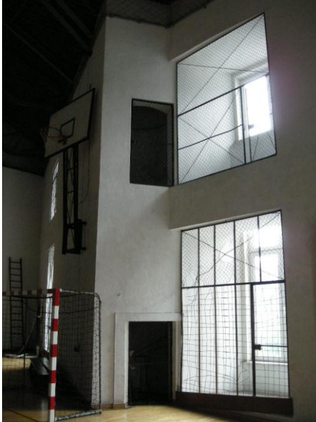
Figs. 70 e 71 – Pormenor do bloco trapezoidal no interior do ginásio do Arsenal da Marinha e que, pese embora as arestas exteriores, é circular no seu interior. Repare-se nas duas aberturas, colocadas a dois níveis, como se de dois pisos se tratasse. O seu interior, circular, não tem qualquer ligação entre os dois níveis, sugerindo uma estrutura que albergou, outrora, uma escadaria em caracol, iluminada pelas duas frestas que ainda são visíveis tanto no interior, como no exterior do edifício (figs. 72 e 73).
