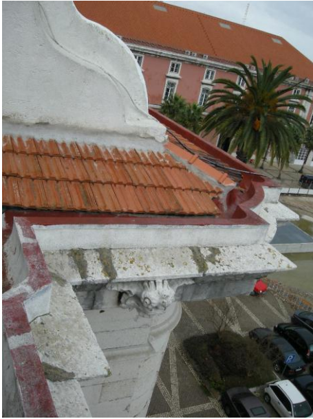
Figs. 91 e 92 – Pormenores da terminação do guarda-fogo, anteriormente arco do fundo de cena do teatro de Lisboa, e o seu apoio na esquina sul do Arsenal da Marinha.
