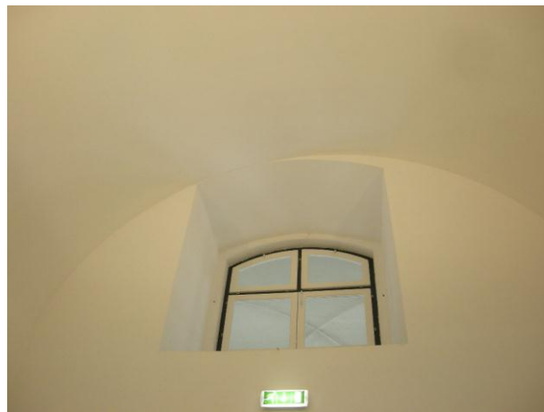
Figs. 35 e 36 – Desfasamento visível entre a abertura das janelas que dão para a galeria de arcos pombalina do lado poente da Praça do Comércio e o sistema de sustentação dos tectos. Erro de cálculo ou aproveitamento de vestígios arquitectónicos previamente existentes? Outra questão para a qual não conseguimos resposta. Fotos do autor.
