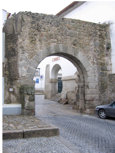
figs. 31-32 e 33: aparelho semelhantes ao de Évora, em outros locais com ocupação islâmica (seg. Pavón); Arco de Santa Isabel- entrada romana, reutilizada em época islâmica, possivelmente com uma entrada mais complexa; rua da Alcárcova de Cima – faces exteriores de torres viradas para a antiga karkaba , ou seja, o fosso.
