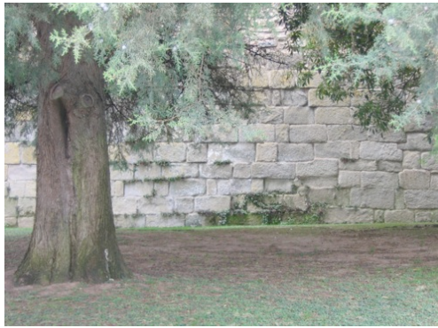
Fig. 29 – muralha romana e alto-medieval em opus quadratum, muito semelhante ao que será conhecido como “soga y tizón” para as fortificações de época islâmica.
