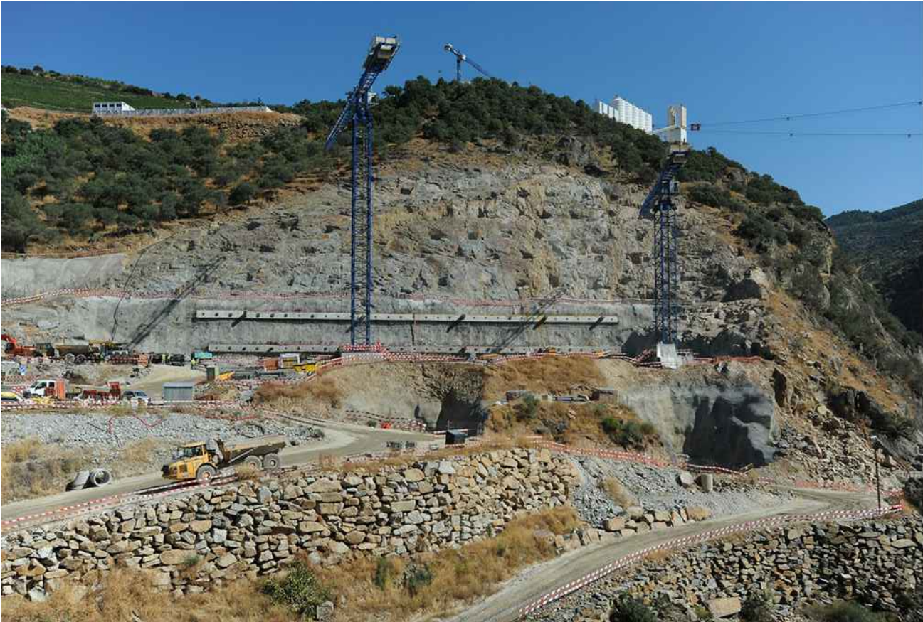
Fig. 7 Obras no Rio Tua
