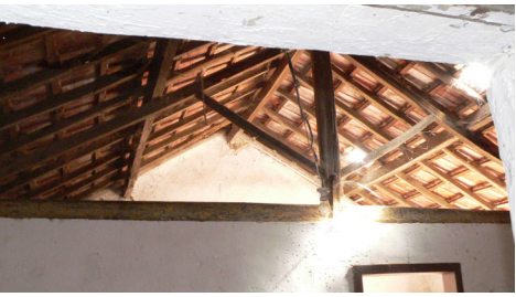
Cobertura de duas águas com recurso a asna assente em parede divisória Vale Vinagre, Santiago do Cacém
