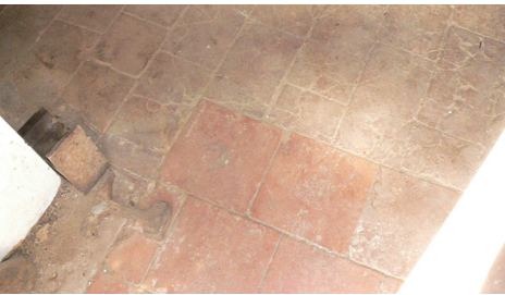
Pavimento em tijoleira rectângular e substituições por tijoleira quadrângular Vale Vinagre, Santiago do Cacém
