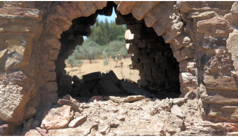
Vão de forno com ombreiras e vergas em tijolo maciço e arco ogival Courela, Santiago do Cacém
