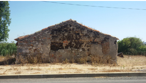
Vão com lintel em tábua de madeira, encerrado com cimento Aldeia de Santo André , Santiago do Cacém
