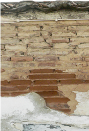
Alvenaria em taipa com camadas visíveis Vale Grande, Ademas, Santiago do Cacém
