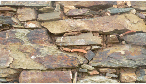
Parede em alvenaria de pedra Monte do Outeiro da Nogueira, Santiago do Cacém
