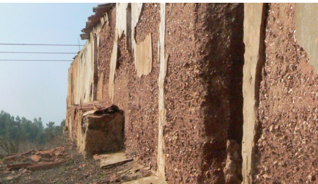
Poial adossado à fachada principal de construção sem embasamento Casa Nova da Nogueira, Santiago do Cacém
