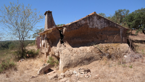
Gigante lateral e forma arredondada no topo da construção Monte da fome, Santiago do Cacém
