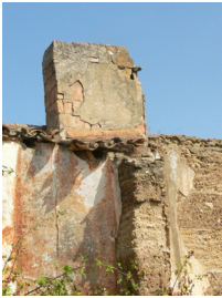
Conjunto de chaminés de localização central na construção com lareira de canto adossada à parede de cumeeira Casa dos mineiros no Monte do Canal, Grândola
