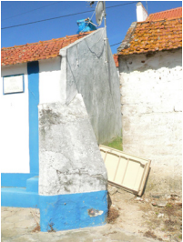
Gigante lateral e forma arredondada na fachada lateral Casa Nova da Nogueira, Santiago do Cacém
