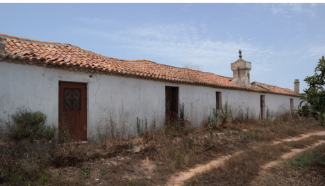
Ritmo de vãos no edifício de acordo. São: portas com postigo em diferentes materiais -madeira ou chapa metálica- e em menor número janelas Boavista, Santiago do Cacém
