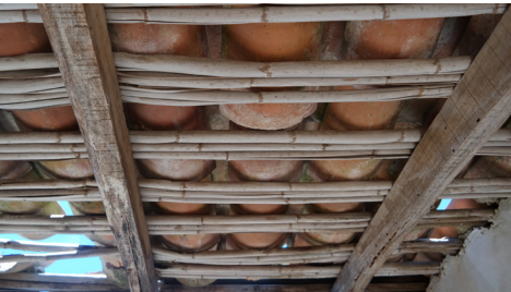
Telha assente em cana Monte da Fome, Santiago do Cacém
