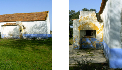
Forno de uma água adossado à fachada lateral da casa, excepcionalmente com abertura para o lado tardo da habitação Corujo, Santiago do Cacém
