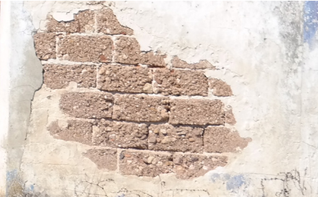
Pormenor de alvenaria de tijolo de adobe. Vale Lagos, Santiago do Cacém
