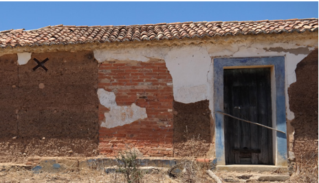
A diferença de material pressupõe o encerramento de um vão Courela, Santiago do Cacém
