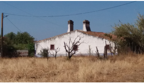
Edifício de habitação com mais do que três alinhamentos de compartimentos. Cobertura de duas águas com pau de fileira alinhado com o eixo central da construção, de secção transversal simétrica. Chaminés adossadas a paredes mestras junto ao eixo de cumeeira. Monte das Brunheiras, Grândola
