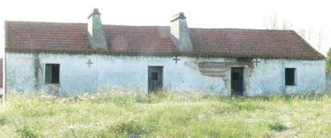
Edifício com duas casas de habitação. Cobertura de duas águas com pau de fileira alinhado com o eixo central da construção, de secção transversal simétrica. Chaminés na parede perpendicular à fachada principal. Herdade de Mascarenhas, Alcácer do Sal
