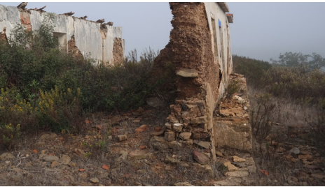
Poial em pedra adossado à fachada principal Monte do Outeiro da Nogueira, Santiago do Cacém
