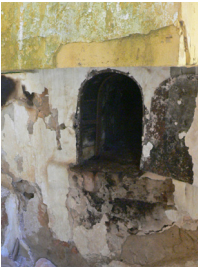
Vão de forno com ombreiras e vergas em tijolo maciço e arco de volta perfeita Tojeira, Grândola
