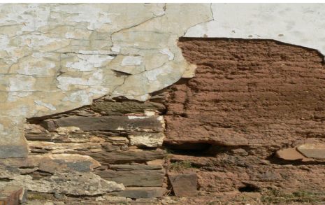
Pormenor da parede em alvenaria de taipa e pedra Caraptal
