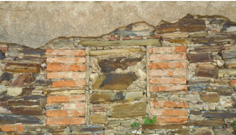
Vão com lintel em tábua de madeira e cantaria em tijolo de burro, encerrado por pedra Boavista, Santiago do Cacém
