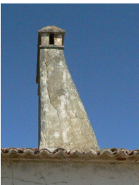
Chaminés com lareiras adossadas à fachada principal, de diferentes dimensões Casas no aglomerado, Grândola
