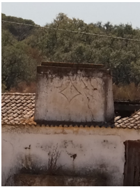
Chaminé de planta rectângular com lareira adossada à fachada principal da construção Monte Velho de Cima, Santiago do Cacém
