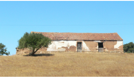
Porta para habitação com cantaria em tijolo de burro e vão para estábulo com tábua de madeira usada a servir de lintel Casa Nova dos dourados, Santiago do Cacém
