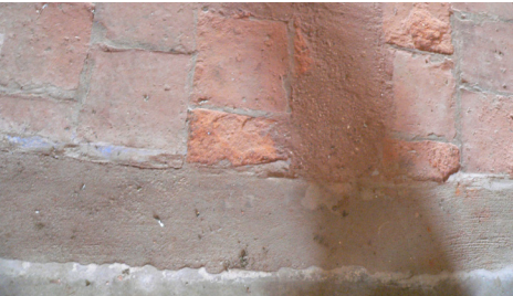
Pavimento em tijoleira rectângular em estereotomia desencontrada Tojeira, Grândola
