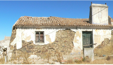
Porta em ripado de madeira, com duas folhas e portigo; janela com portadas interiores em madeira Habitação em São Bartolomeu, Santiago do Cacém
