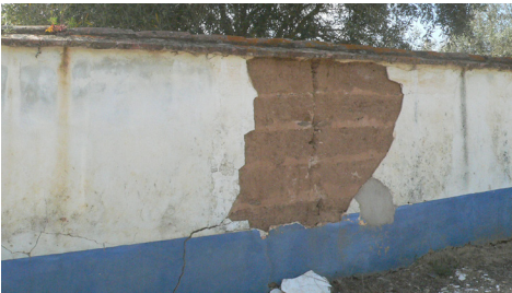
Muro em taipa com capeamento para protecção das águas pluviais Brunhal, Ferreira do Alentejo
