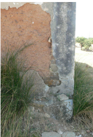
Cunhal da parede exterior em pedra e revestido com argamassa feita à base de cimento Boavista, Santiago do Cacém
