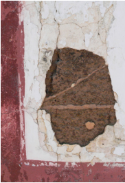
Fissura em parede de alvenaria em taipa Casito, Santiago do Cacém
