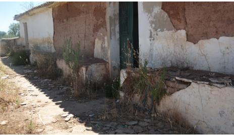
Poial adossado a toda a fachada principal da casa e na lateral junto ao forno Casito, Santiago do Cacém
