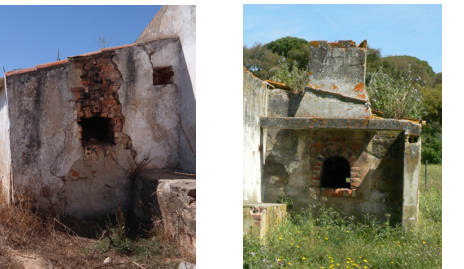
Forno de uma água adossado à fachada lateral da casa, com poial de forno Casito, Santiago do Cacém
