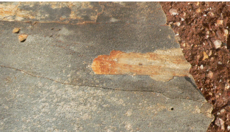
Destacamento do revestimento à base de cal, em parede de taipa Courela, Santiago do Cacém
