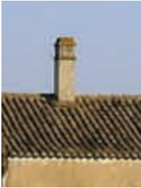
Chaminé de planta de secção quadrada localizada no centro da construção, com lareira adossada à parede de cumeeira Alcaria da Ribeira Santiago do Cacém
