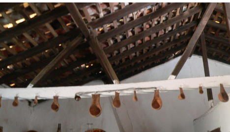
Cobertura de duas águas com recurso a asna de madeira Tanganhal, Grândola
