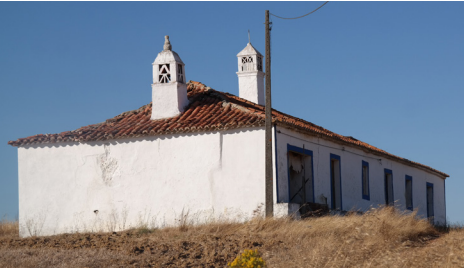
Alpedre do forno, formando uma cobertura do conjunto de três águas Rochinha, Santiago do Cacém
