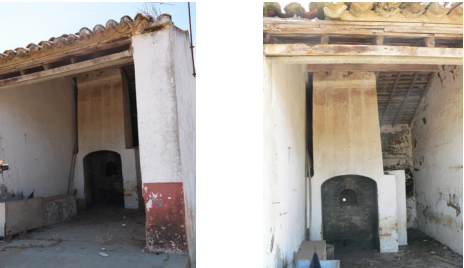
Forno adossado à fachada lateral da casa, sob alpendre Enxacfres, Grândola
