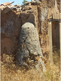
Contrafortes de forma arredondada na esquina do edifício Courela, Santiago do Cacém
