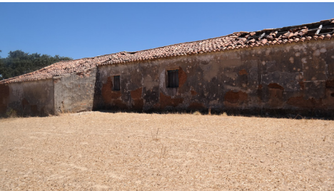
Edifício de habitação com um alinhamento de compartimentos e outro compartimento para animais a tardoz, , sob a mesma cobertura, apenas com um vão de entrada na fachada lateral da casa. Cobertura de duas águas com pau de fileira alinhado com o eixo central da construção, de secção transversal simétrica. Não se regista existência de chaminé. Forno de pão adossado à fachada lateral do quadrante sul. Courela, Santiago do Cacém
