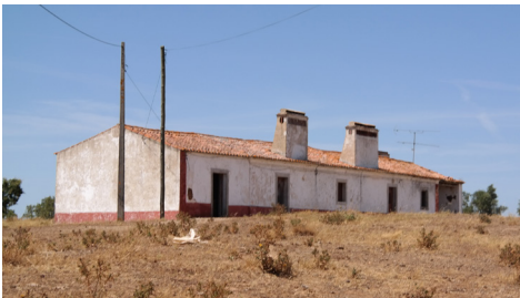
Monte com duas casas de habitação e forno adossado, sob alpedre. Todo o conjunto está sob a mesma cobertura, de eixo central e secção transversal simétrica. Chaminés no alinhamento da fachada principal. Enxacafres, Grândola
