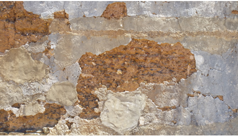
Alvenaria em taipa e reboco de cal. Monte da Fome, Santiago do Cacém
