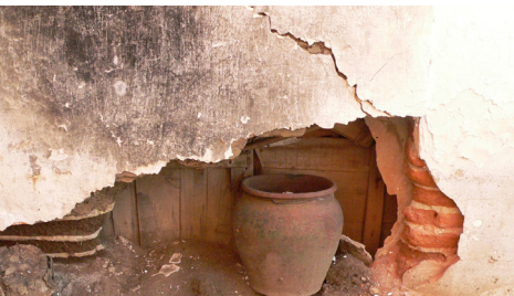
Duas paredes em taipa de diferentes composições. Brunhal, Ferreira do Alentejo
