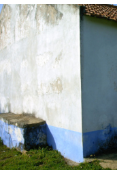
Poial em pedra adossado à fachada principal e soco pintado Carapetal, Santiago do Cacém
