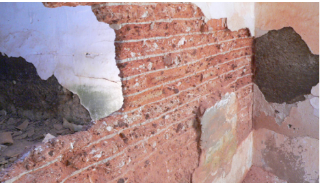
Parede interior em taipa e destacamento do revestimento à base de cal Courela, Santiago do Cacém
