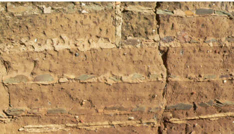
Fissura em parede de alvenaria em taipa sob camadas de pedras, sem revestimento Monte da Herdade do Canal, Grândola
