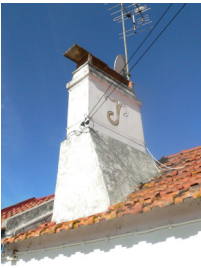
Chaminés de planta rectângular com lareira adossada à parede transversal Arez, Grândola
