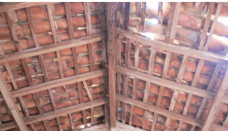
Cobertura da cozinha com telha assente em ripado e barrotes de madeira Courela, Santiago do Cacém
