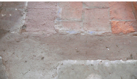
Pré-existência de paredes interiores visível a partir das variações de revestimento do pavimento Monte da Tojeira, Grândola
