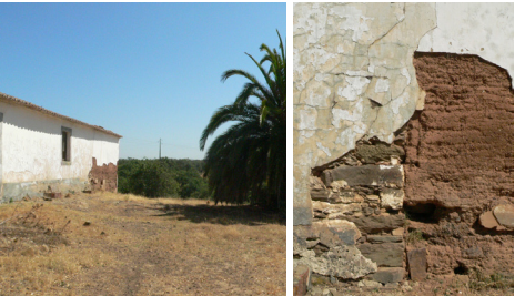
A diferença de material pressupõe a adição de um compartimento posterior à construção inicial Carapetal, Santiago do Cacém
