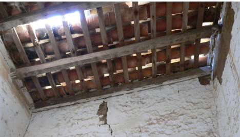
Cobertura de um compartimento com telha assente em ripado de madeira Carapetal, Santiago do Cacém
