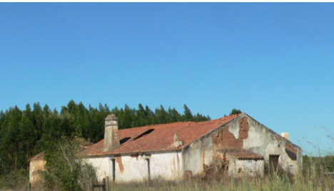
Edifício de secção transversal alongada com dois alinhamentos de compartimentos. A cobertura de duas águas assenta na parede de cumeeira. Chaminé adossada à parede da fachada principal. Forno adossado à fachada lateral norte com cobertura de uma água e poial de forno no exterior. Vale do Chiqueirinho, Santiago do Cacém
