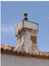
Chaminés de planta de secção quadrada, com lareiras adossadas à fachada principal da casa, de diferentes dimensões Boavista, Santiago do Cacém
