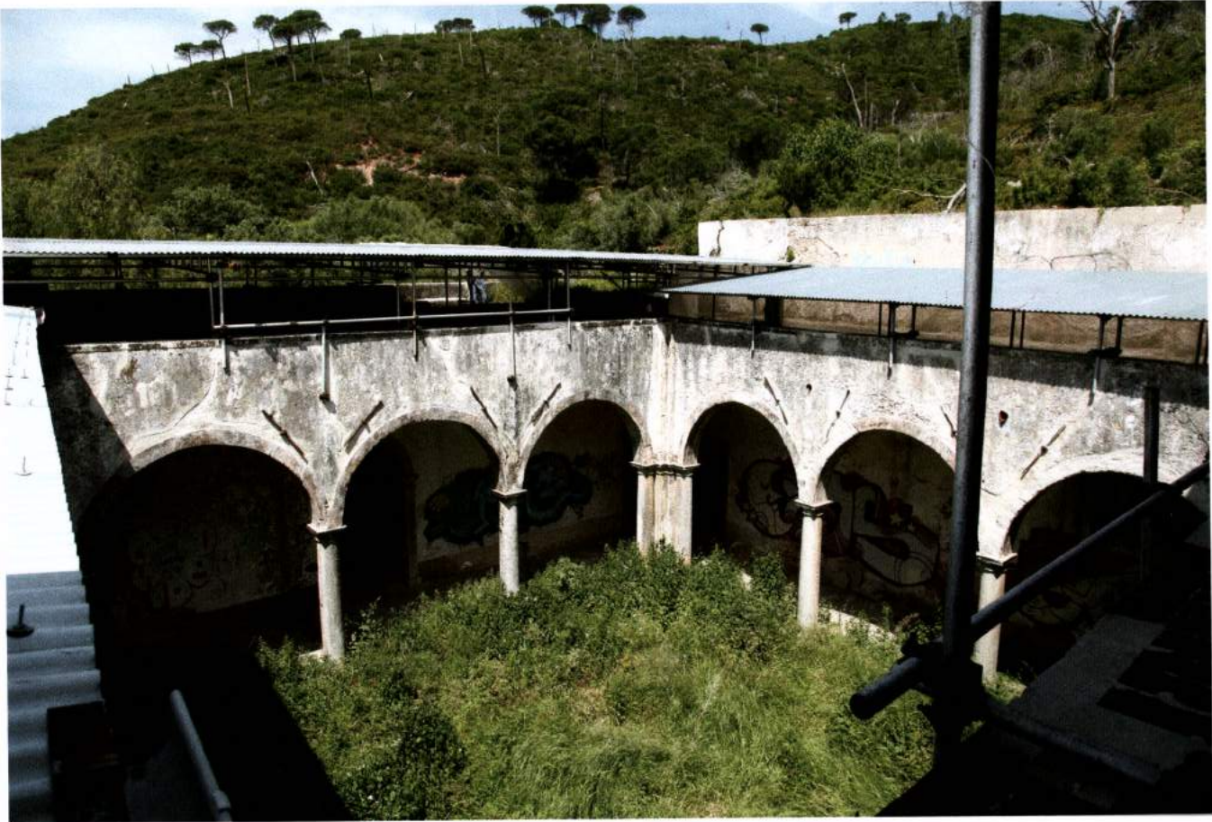
Claustro - do Convento de São Paulo
