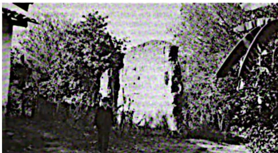
Figure 3.4. Germano Graeser [Photographe], 1937. « Ruínas da chácara « Morumbi ». Dans la photographie, un des techniciens du SPHAN pose devant les ruines d'un murs em taipa de pilão . Arquivo do SPHAN RJ.
