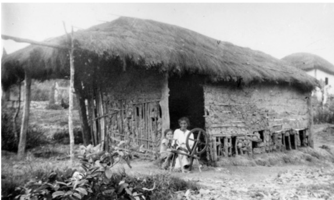
Figure 2.21. [auteur inconnu], Exemple de cafua avec de grandes fissures, murs en argile non enduit. De l'expédition scientifique de Lassance de 1907. Source : Institut FIOCRUZ.
