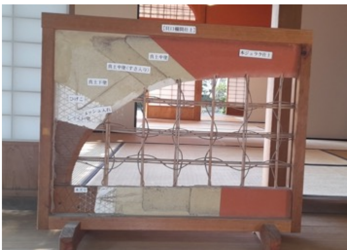
Figura 27. Modèle d'un mur en terre crue « tsuchikabe » dans une typique maison sukia japonnaise. L'expertise technique est supérieure à celle que nous trouvons dans le « pau-a-pique » brésilien, bien que l'entrelacement des tiges soit très similaire à ce que nous trouvons au Brésil. Photo prise à Kagoshima, Janvier 2024, DKC.
