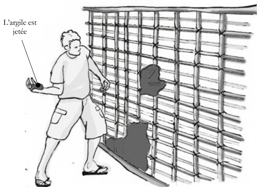
Figure 1.3. Lancement d'argile de la « taipa de sopapo », selon Weimer.
