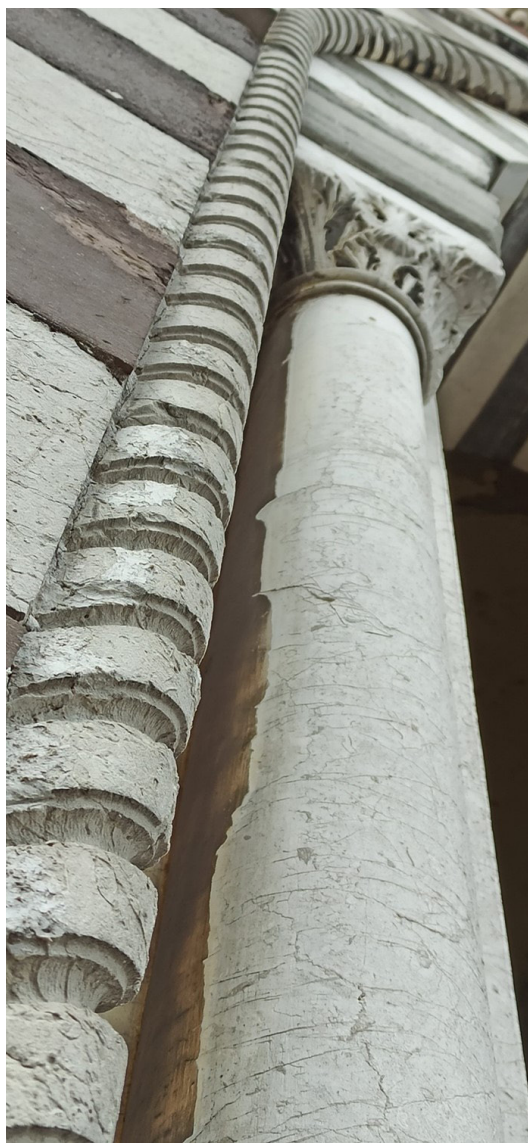
FIGURA 2 | Deposição de partículas atmosféricas e poluentes por deposição seca em pedra calcária, resultando na formação de crostas negras (principalmente sulfáticas) nas áreas protegidas do escoamento difuso da água da chuva.
